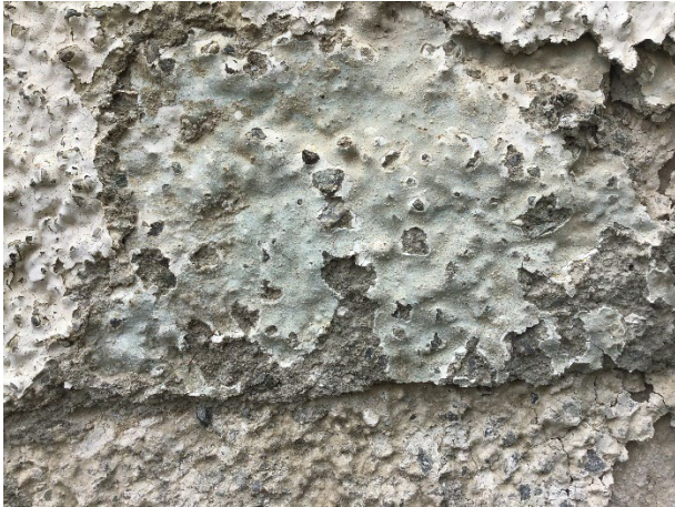
Bild: Detailaufnahme Spritzrieselwurf und farbiger Kalkanstrich Nullfläche
