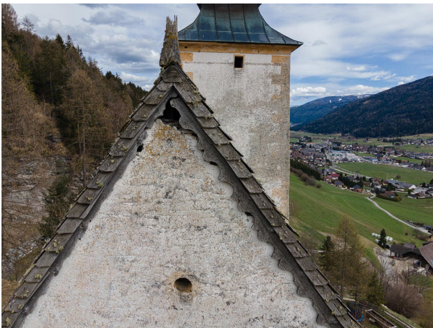
Bild: Detailaufnahme Westseite > stark erodierte Oberfläche
