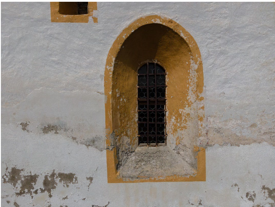
Bild: Detailaufnahme Langhaus Südseite – mit einzelnen, zeitlichen Putzebenen
