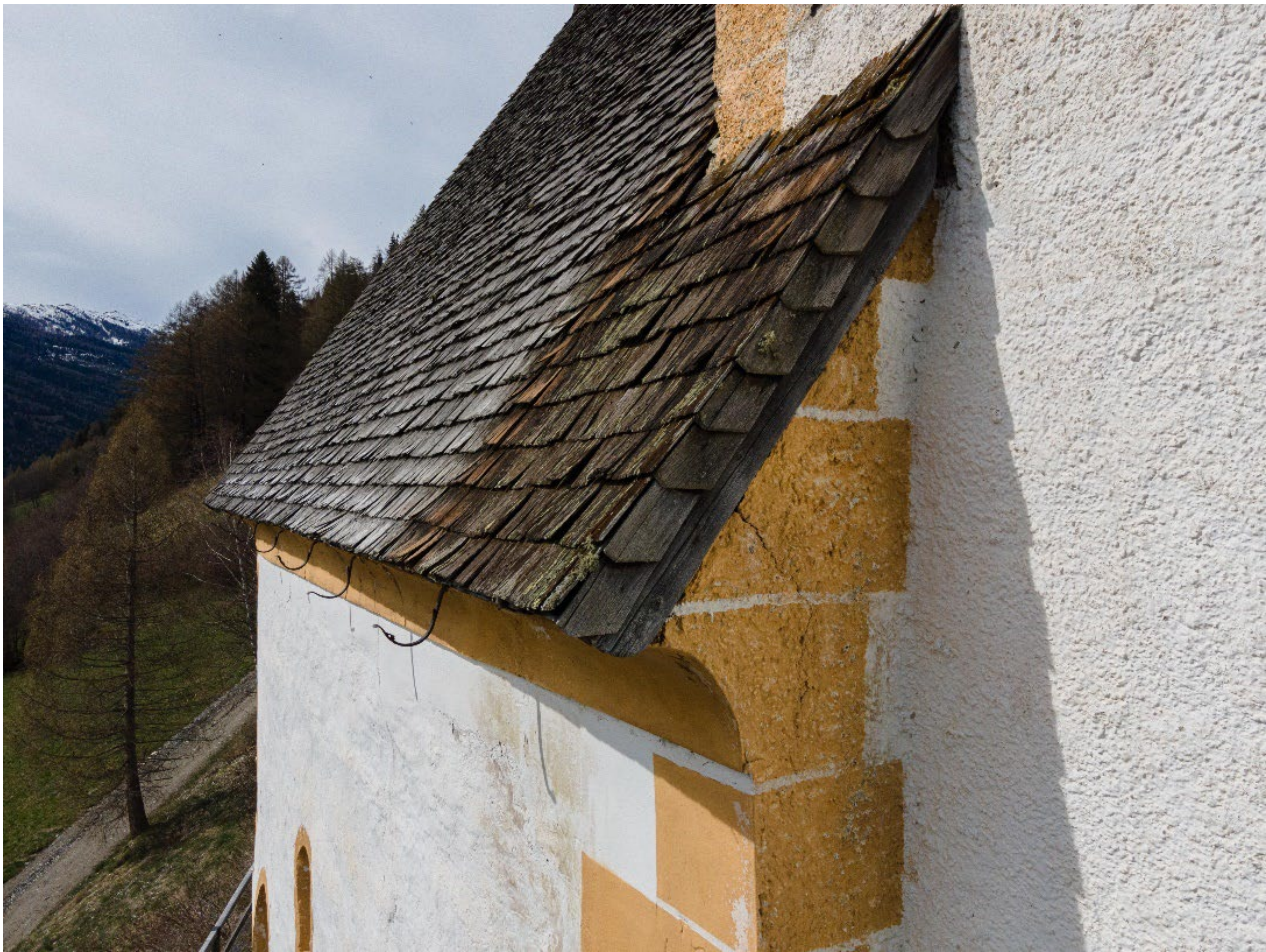
Bild: Detailaufnahme Langhaus Südseite > Anschluss Hohlkehlegesimse und geglättete Übergangsfläche
