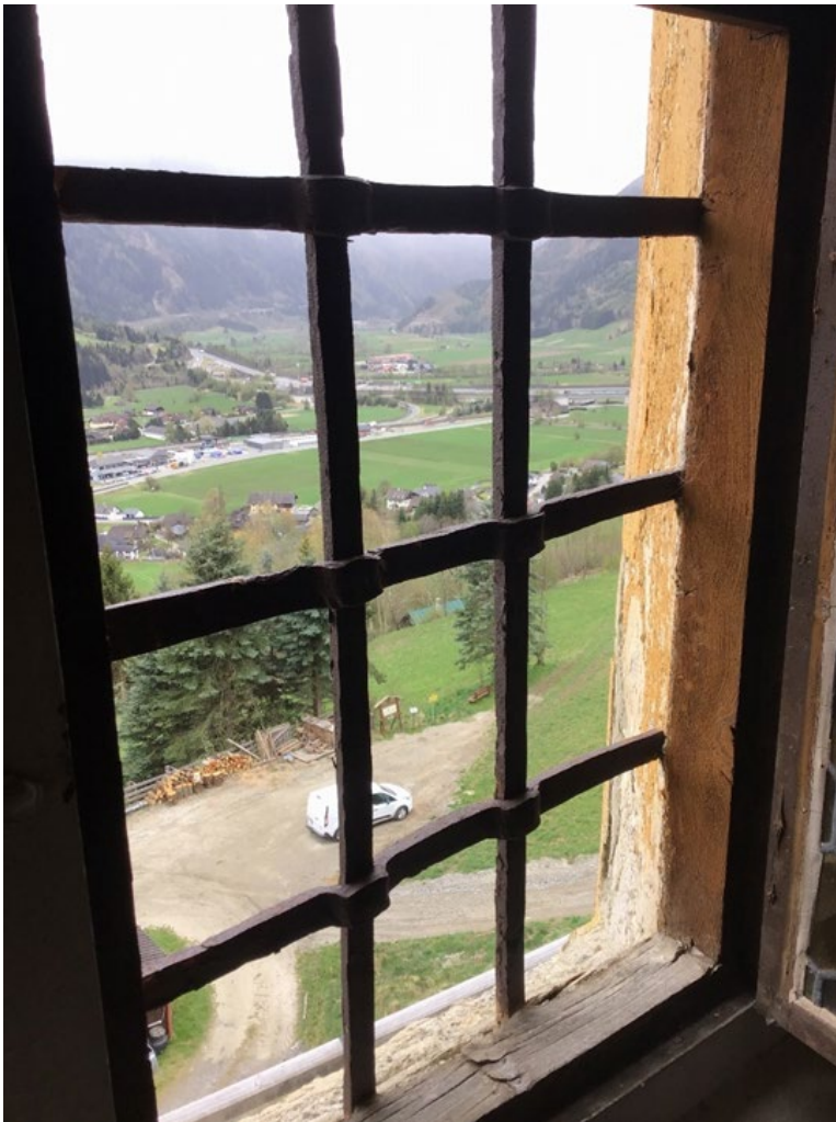
Bild: Detailaufnahme Architekturöffnung Langhaus Süd > spätgotisches Stabgitterwerk
