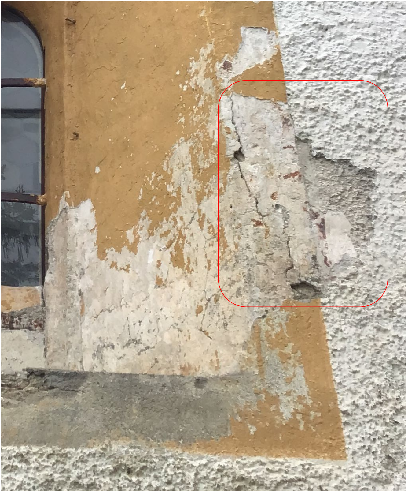
Bild oben: Detailaufnahme Fensterrahmung Turm Ostseite geglättete Fensterrahmung mit geritztem Fugenstrich Anschluss Spritzwurf
