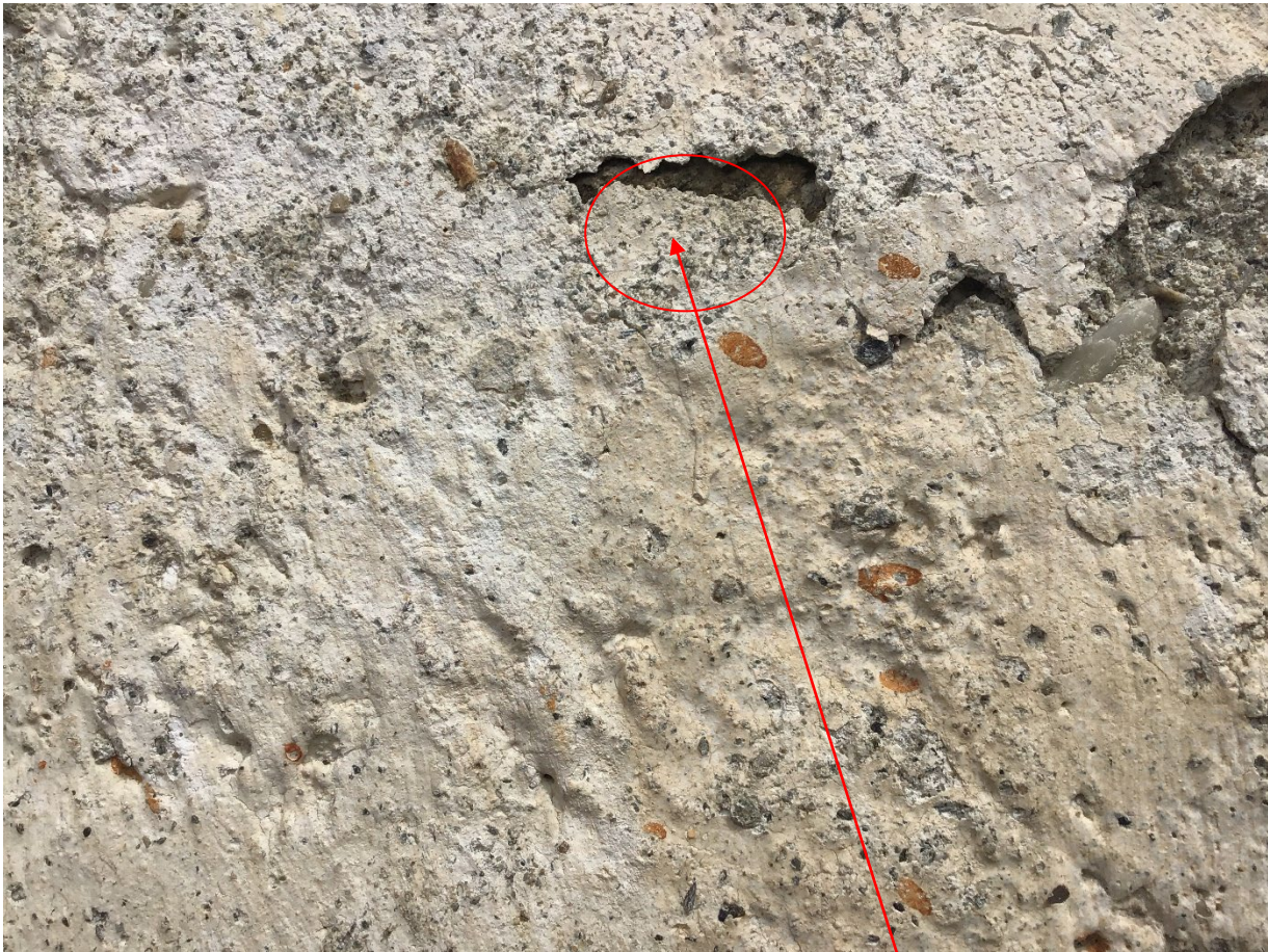
Bild oben: sichtbarer, gotischer Schlämmauftrag (Kornkurve 0-6mm)
