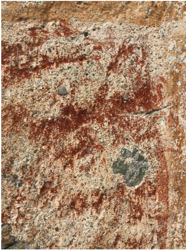
Bild oben: Detailaufnahme Turm Südseite – Chorraum (unteres Drittel): geglättete, romanische Putzoberfläche mit zweifarbiger Bemalung im wechselseitigen Verbund
