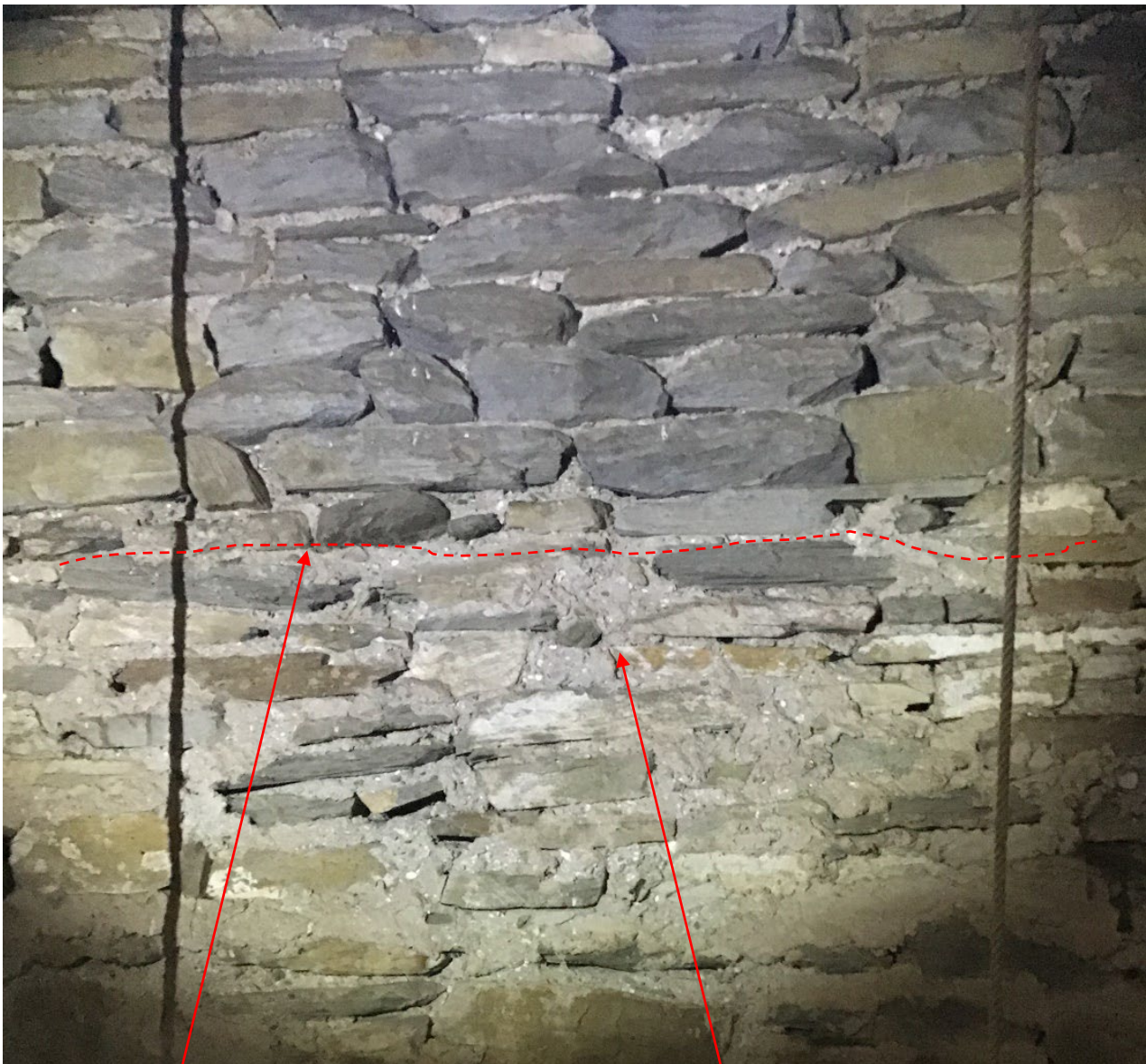
Bild oben: Zweites Obergeschoss Turm. Sichtbare Baunaht der barocken Erweiterung
