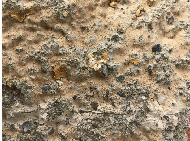
Bild: Detailaufnahme Eckquaderung > farbiger Kalkanstrich mit weißem Fugenstrich
