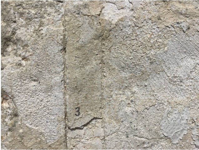
Bild oben: Detailfoto Langhaus Südseite barocke Ritzung der Eckquaderung
