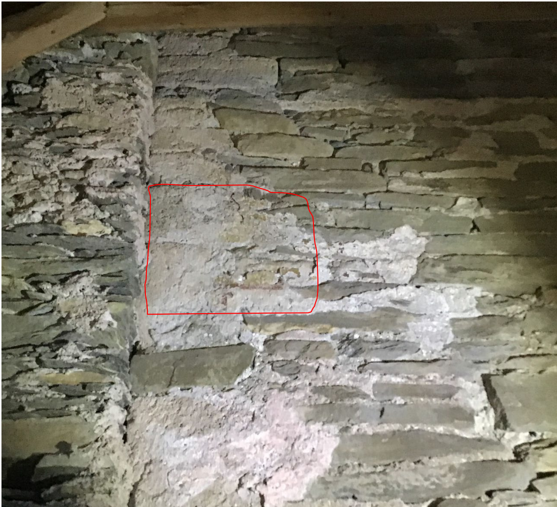
Bild oben: Restfragmente des romanischen Kalklagenputzes mit färbigen Restfragmenten der spätgotischen, gemalten Eckquaderung.
