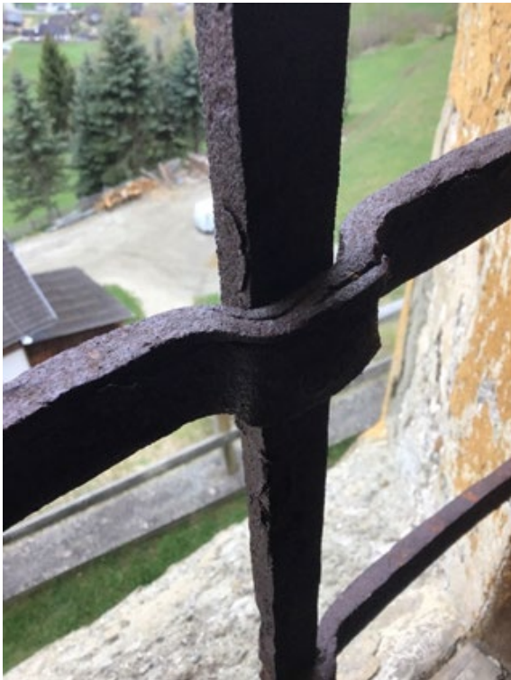
Bild: Detailaufnahme spätgotisches Stabgitterwerk
