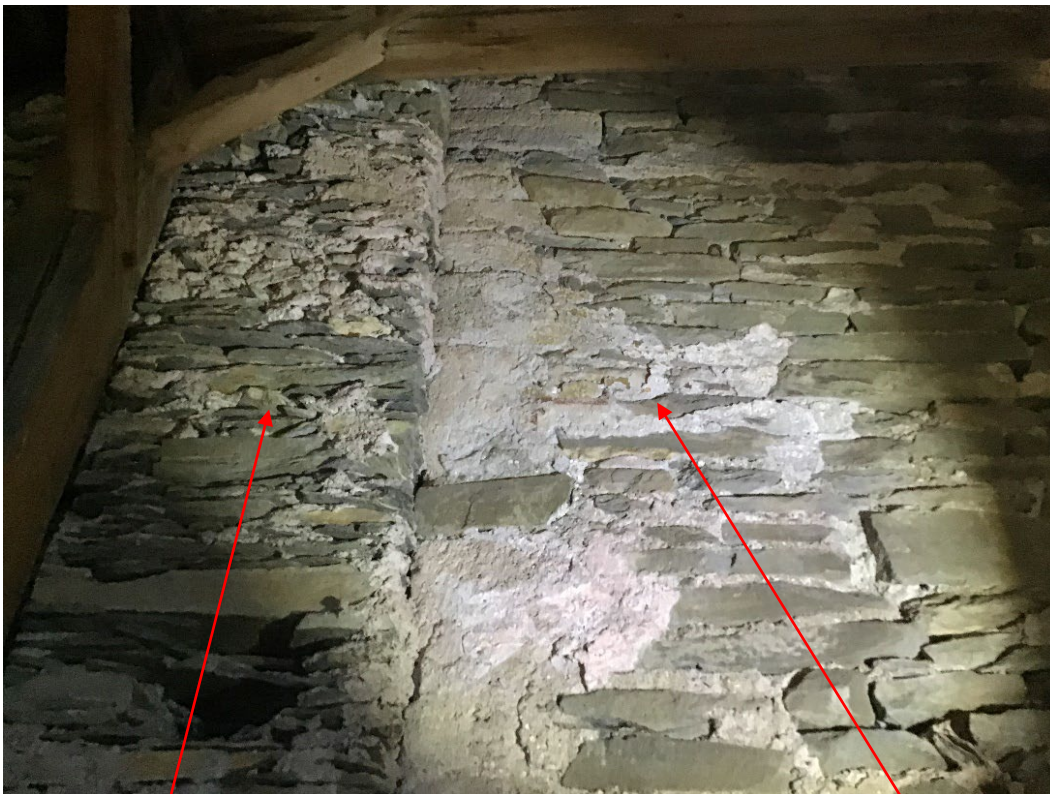
Bild: Detailaufnahme Dachboden > Baunaht zum barocken Erweiterungsbau
