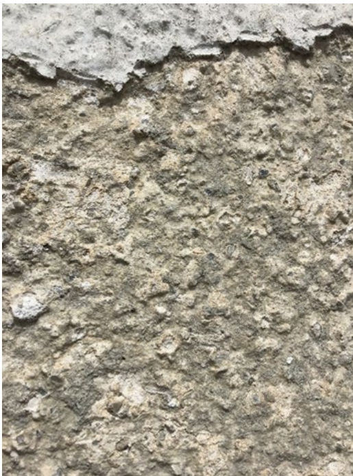
Bild oben: Detailfoto Turm Ostseite: barocker Rieselwurf (Kornkurve 0-6mm)
