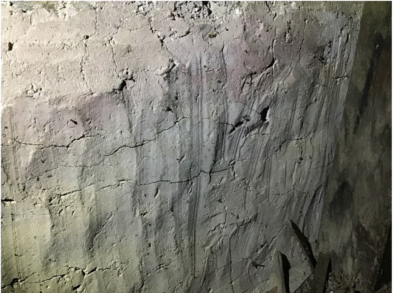
Bild oben: Werkspur des geglätteten, romanischen Kalkmörtels in der Eingangsturmkammer
