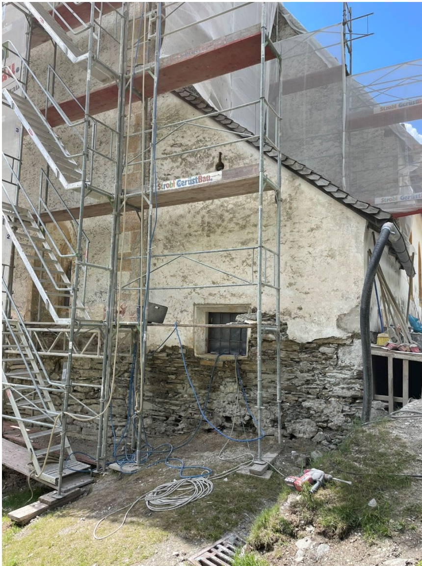
Foto: Händisches Abklopfen / Abnehmen Putzbestände (Zementputzmörtel)
