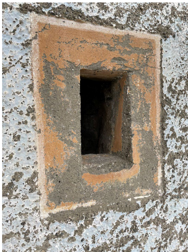
Foto: nach Abnahme der Dispersionsfarbe
