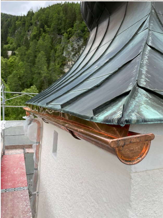
Fotos: Detailaufnahmen Dachrinnen & Ablaufrohr > nach Fertigstellung
