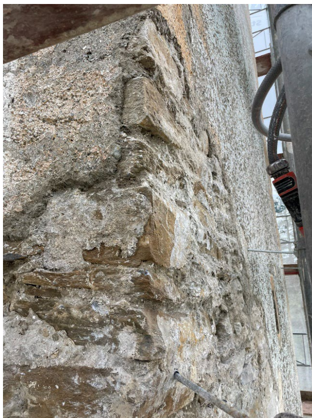
Fotos: Händisches Abklopfen / Abnehmen Putzbestände (Zementputzmörtel)
