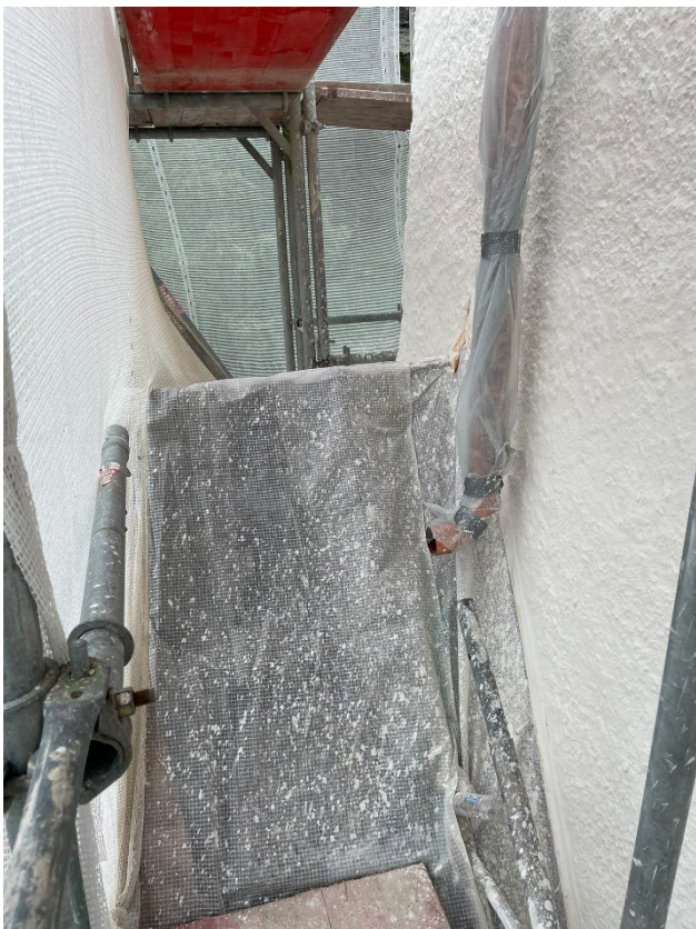
Fotos: Schutzfließmatten Langhausdachanschluss / Turm westseitig
