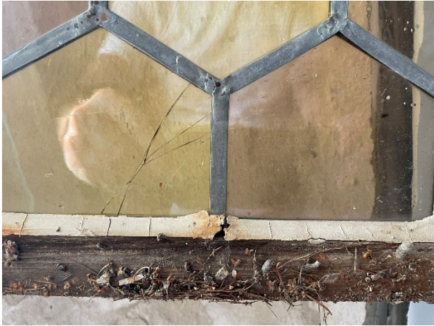
Fotos: Glassanierung Chor - Apsisfenster Ost > Detailaufnahmen Vorzustand
