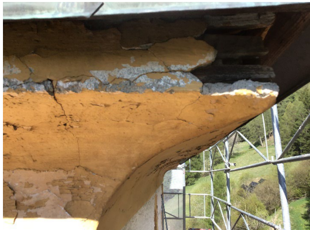
Fotos: Detailaufnahmen Gesimse – Anschluss Dach / Vorzustand (Mai 2025)
