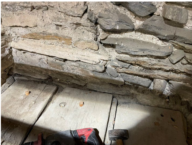
Fotos: Ergänzungen fehlende Holznägel (Lärchenholz) an Geschossbretterboden
