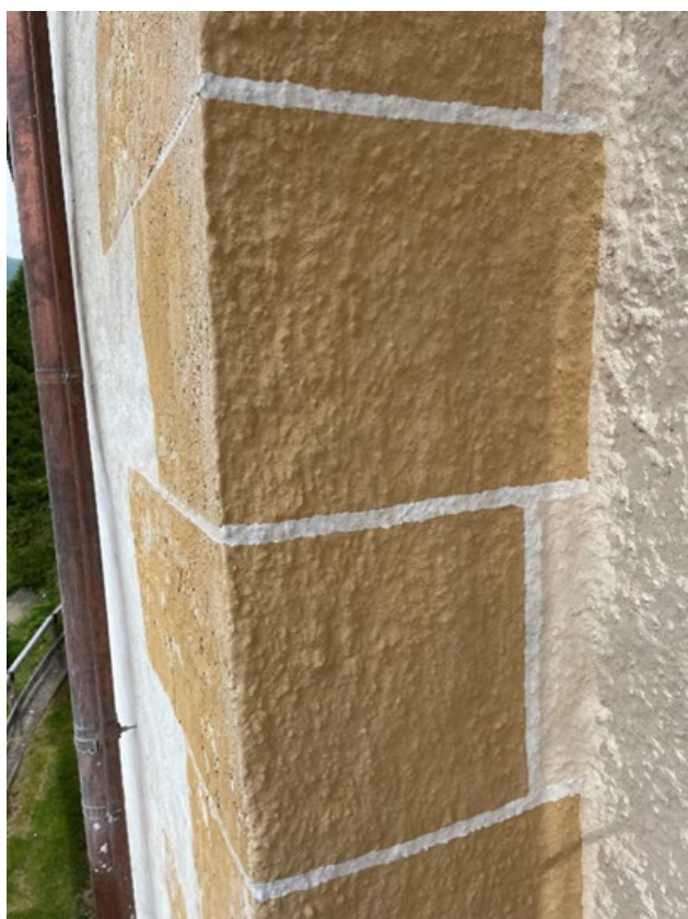
Fotos: Ockerfärbiger Kalkanstrich an der Architekturgliederung – mit weißem Fugen- & Begleitstrich
