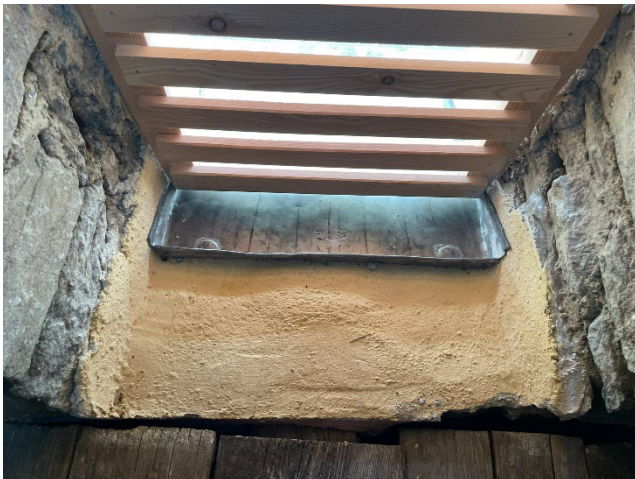
Fotos: Innen- & Außenansicht Glockenstube > Bleiabdeckungen Fensterbrüstungen
