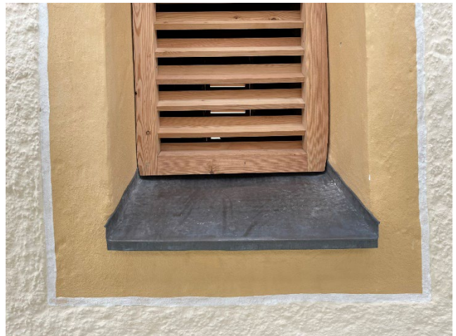
Fotos: Innen- & Außenansicht Glockenstube > Bleiabdeckungen Fensterbrüstungen
