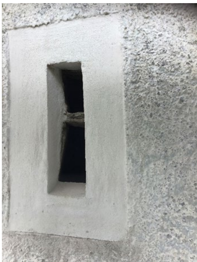
Fotos: Putzmörtelreparaturen zum Bestand > Feinputzglättungen
