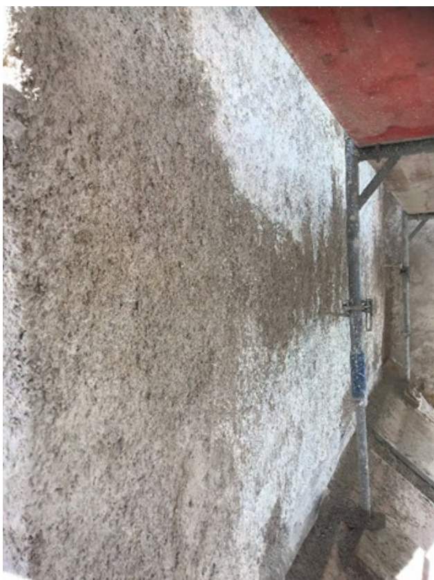
Fotos: Putzmörtelreparaturen zum Bestand > Lagenputz mit Spritzwurf
