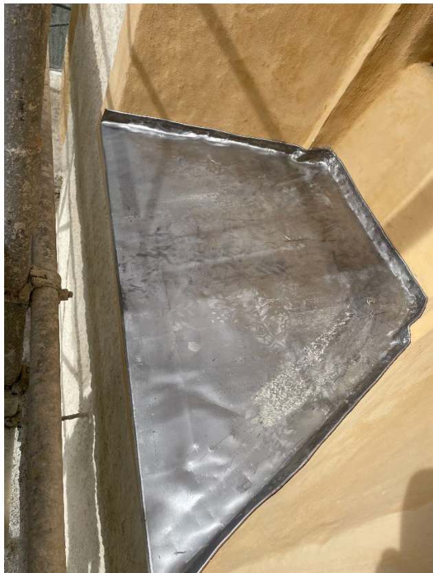
Fotos: Detailaufnahmen Bleiabdeckungen Fensterbrüstungen / Parabete Apsis Ost- und Südseitig
