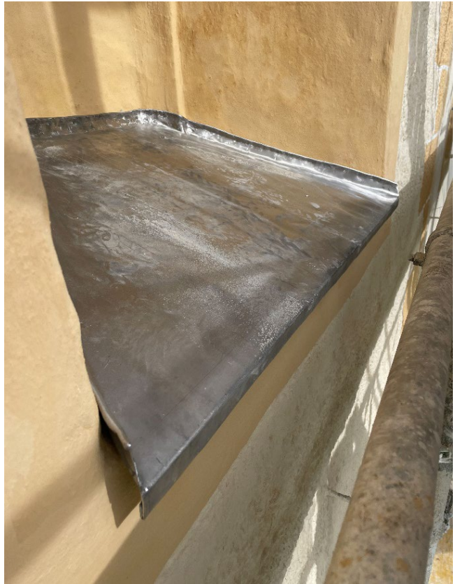
Fotos: Detailaufnahmen Bleiabdeckungen Fensterbrüstungen / Parabete Apsis Ost- und Südseitig
