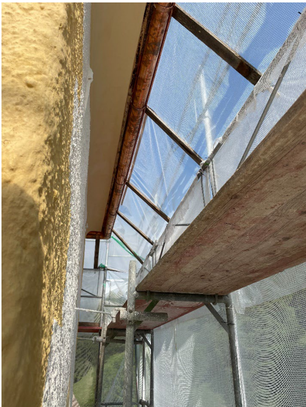
Fotos: Wetterschutzdach (oberste Gerüstebene Turm, umlaufend Nord/West/Süd/Ostseite)
