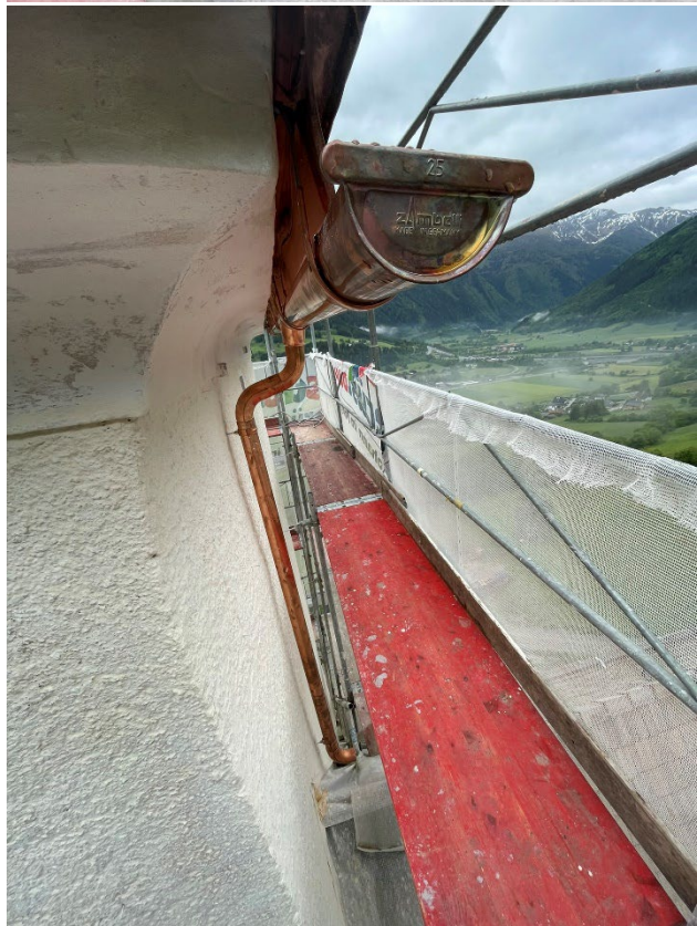
Fotos: Detailaufnahmen Dachrinnen & Ablaufrohr > nach Fertigstellung
