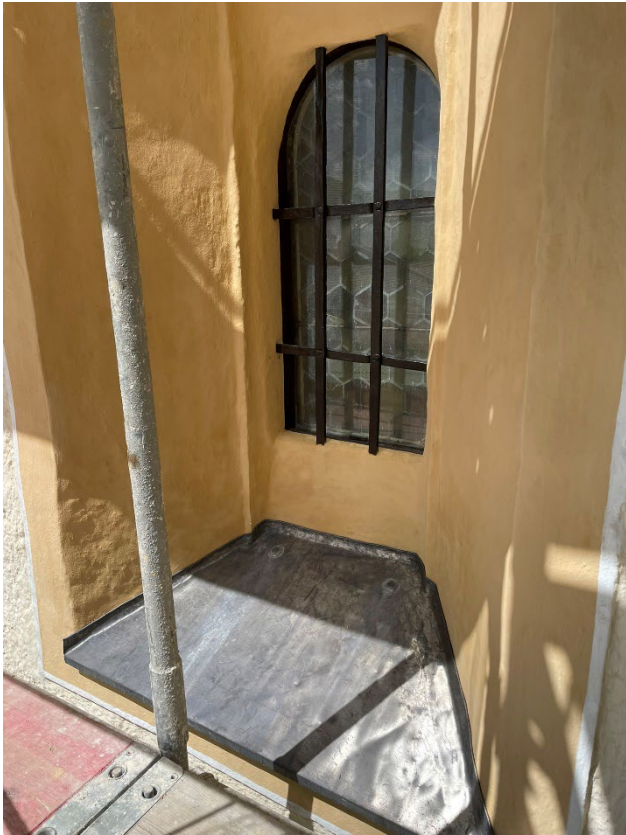
Fotos: Detailaufnahmen Bleiabdeckungen Fensterbrüstungen / Parabete Apsis Ost- und Südseitig
