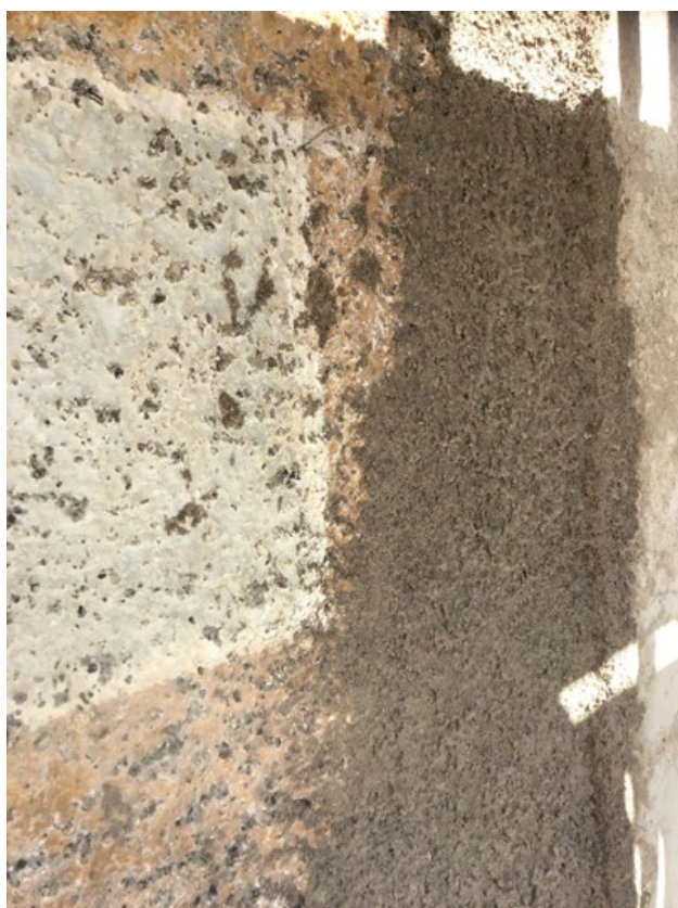
Fotos: Putzmörtelreparaturen zum Bestand > Lagenputz mit Spritzwurf
