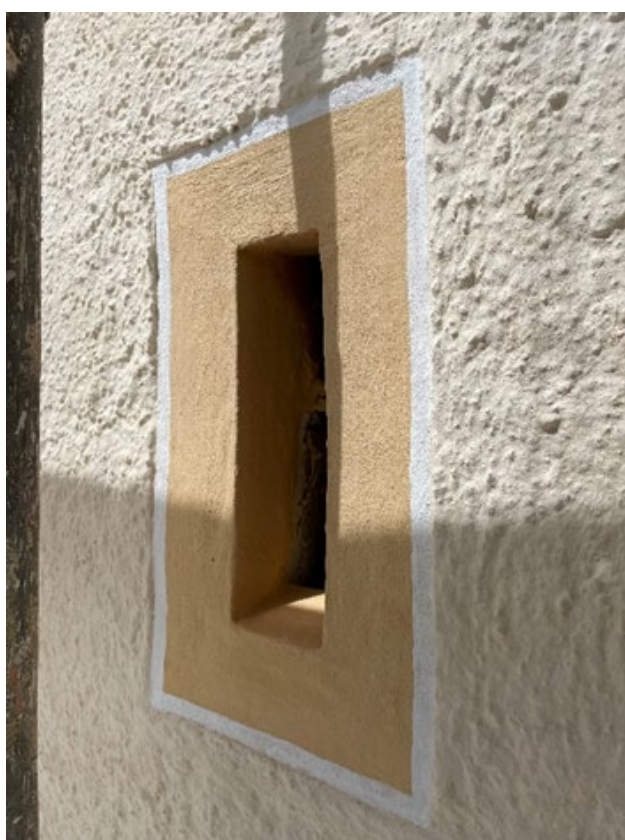
Fotos: Ockerfärbiger Kalkanstrich an der Architekturgliederung – mit weißem Fugen- & Begleitstrich
