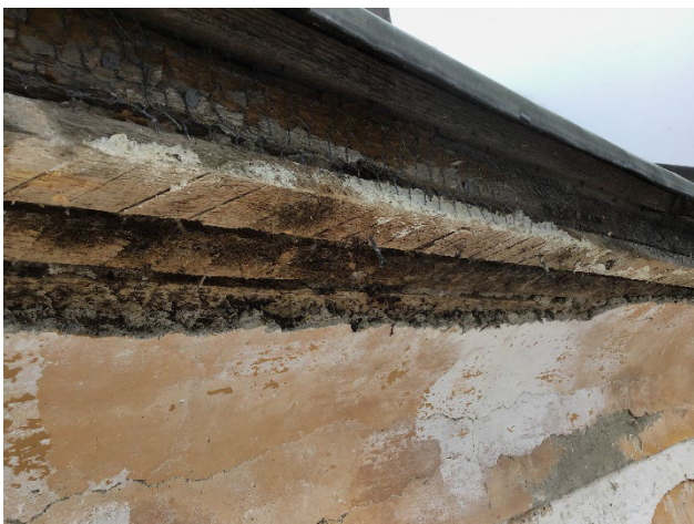
Fotos: Detailaufnahmen > Putzsicherung / Verkleben Gesimse
