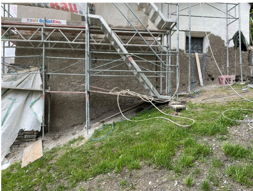
Foto: Putzmörtelreparaturen zum Bestand > Lagenputz mit Spritzwurf
