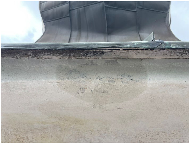
Foto: Feuchtigkeitseindrang vor dem Schließen der Einschusslöcher am Zwiebeldach
