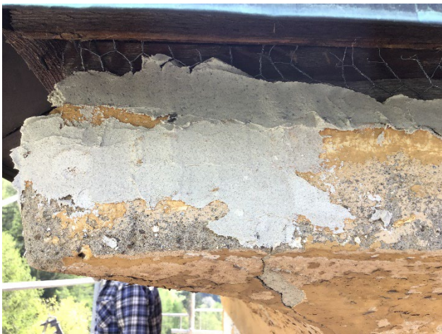
Fotos: Detailaufnahmen > Putzsicherung / Verkleben Gesimse
