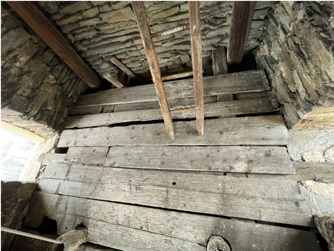
Fotos: Vorzustand Bretterboden Glockenstube
