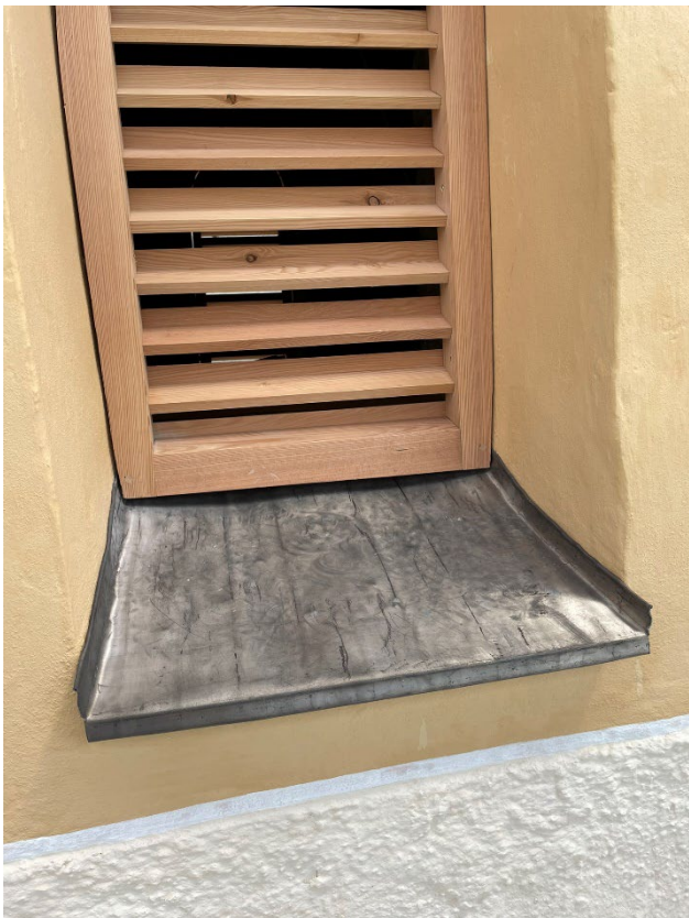
Fotos: Detailaufnahmen Bleiabdeckungen / Fenster Glockenstube
