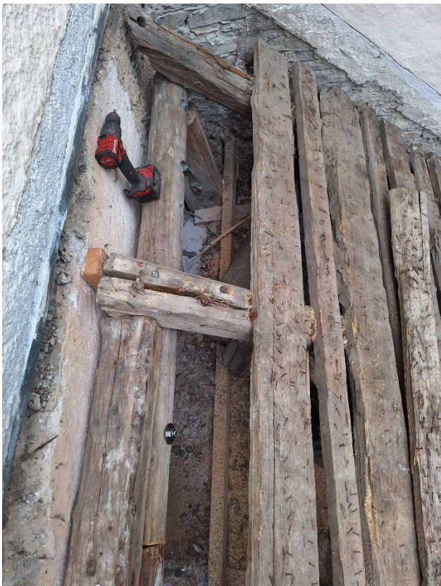
Fotos: Reparaturen - Auswechseln der querliegenden Balken / Wandanschluss zum Turm > im Altholzbestand
