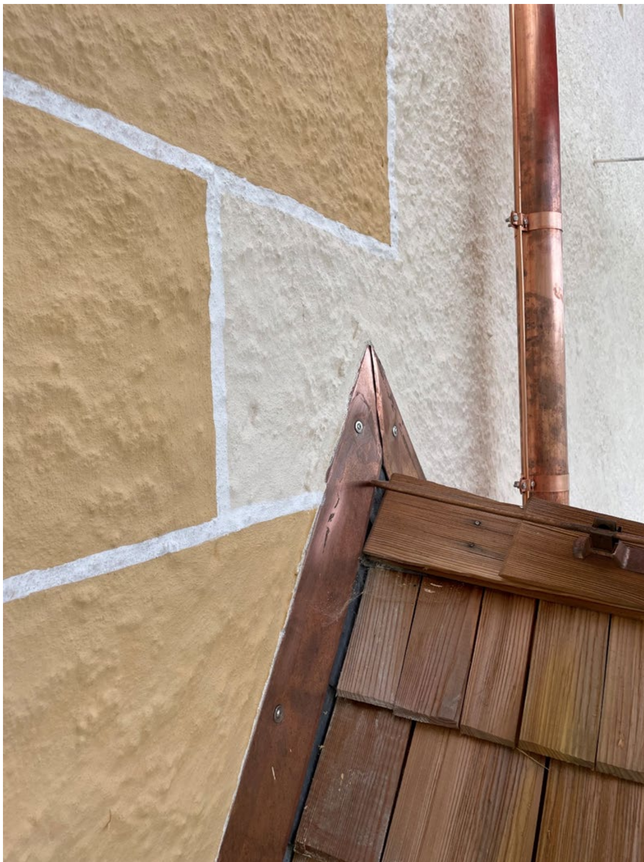
Foto: Ockerfärbiger Kalkanstrich an der Architekturgliederung - mit weißem Fugen- & Begleitstrich
