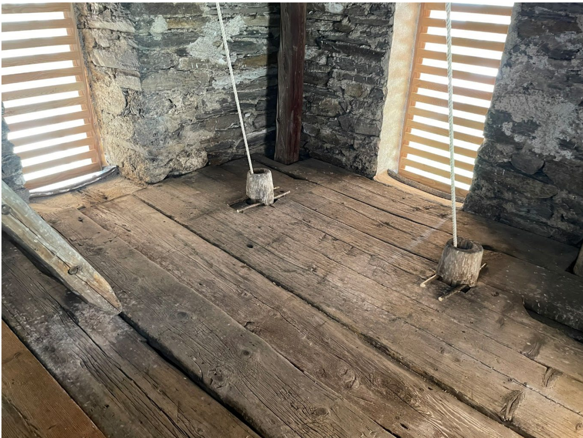
Fotos: Geschossbretterboden Glockenstube > nach Fertigstellung > gereinigter Fußboden und Ergänzung
