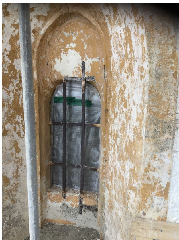
Fotos: Sicherheits- und Schutzmaßnahmen an den Architekturöffnungen während der Sanierungsarbeiten
