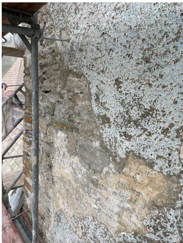
Fotos: Händisches Abklopfen / Abnehmen Putzbestände (Zementputzmörtel)
