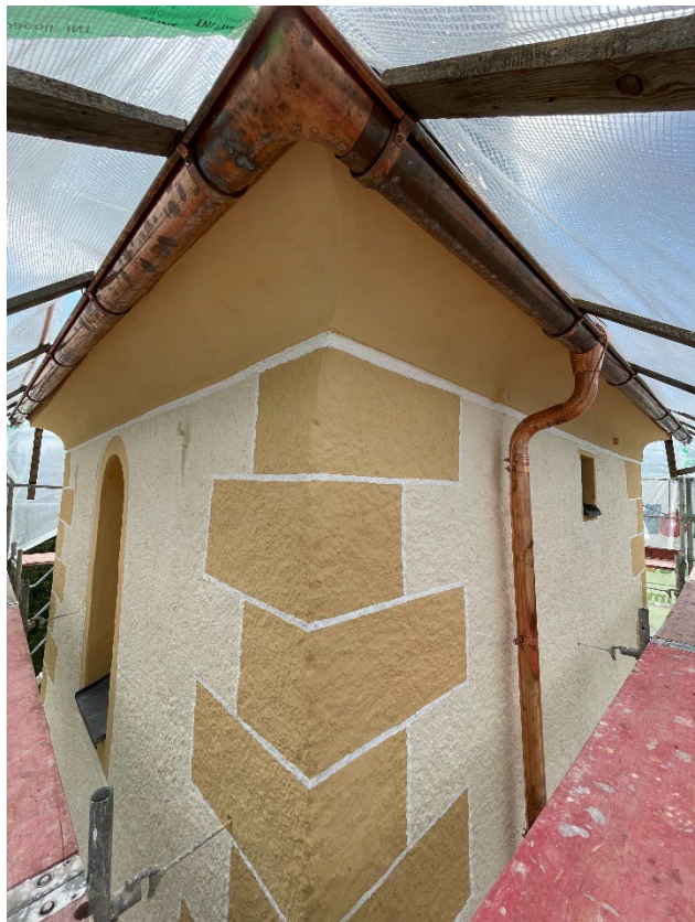
Fotos: Detailaufnahmen Dachrinnen & Ablaufrohr > nach Fertigstellung
