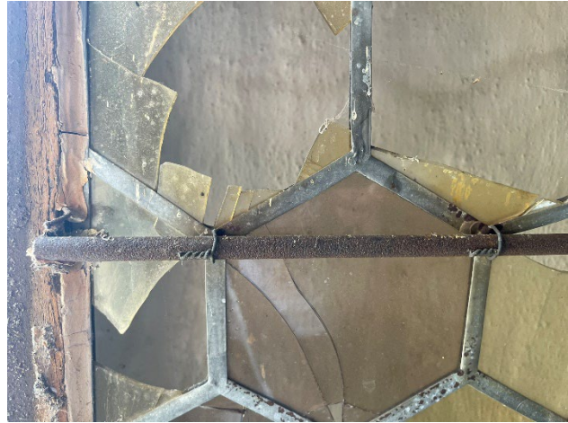
Fotos: Glassanierung Chor - Apsisfenster Ost > Detailaufnahmen Vorzustand
