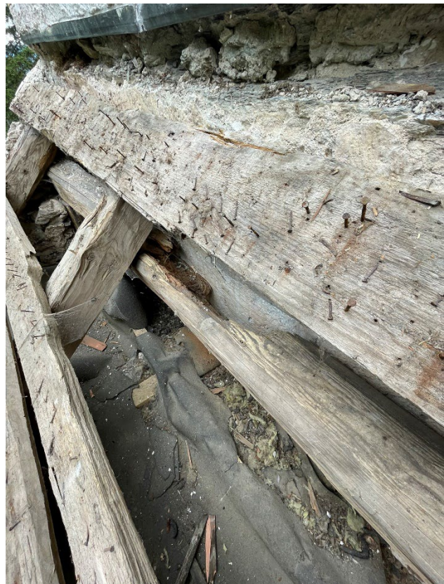
Fotos: Reparaturen - Auswechseln der querliegenden Balken / Wandanschluss zum Turm > im Altholzbestand
