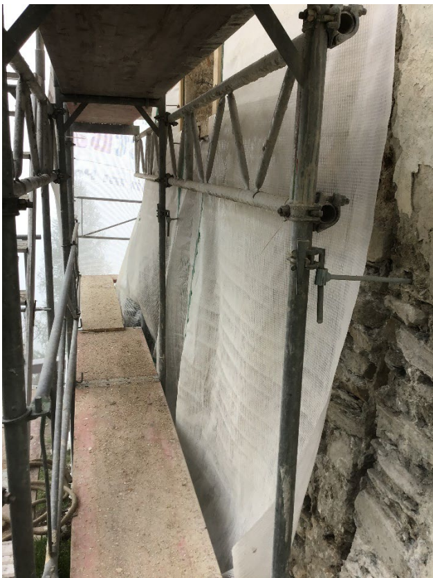
Fotos: Schutzfließmatten mit Mauerhochzug
