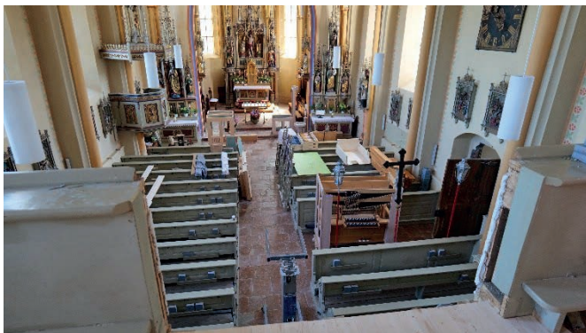
Die offene Empore für den Einbau der neuen Orgel
