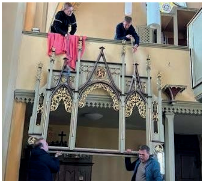
Abbau des denkmalgeschützten Orgelprospekts.
