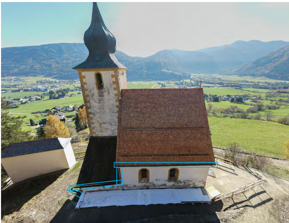
Oberflächenwasserableitung Nordseitig
