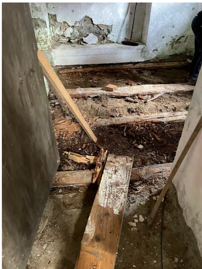
Beginn der Abbrucharbeiten am Sakristeiboden > starke Feuchtigkeitseintritte durch die Außenmauer
