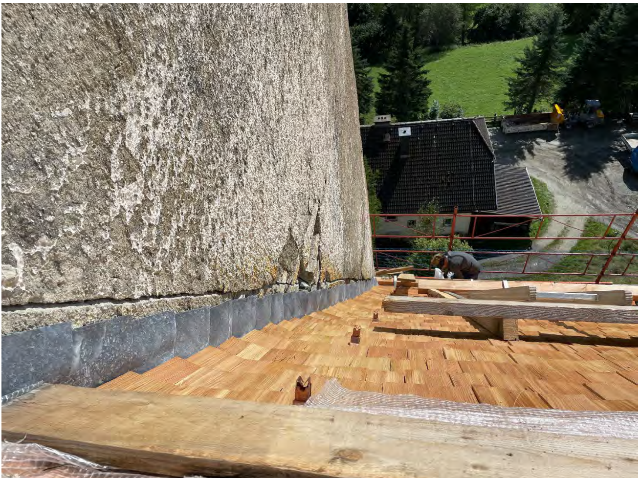
Anschluss Hochzug der Schindeldeckung mit Bleihochzug in den einzelnen Deckungslagen
