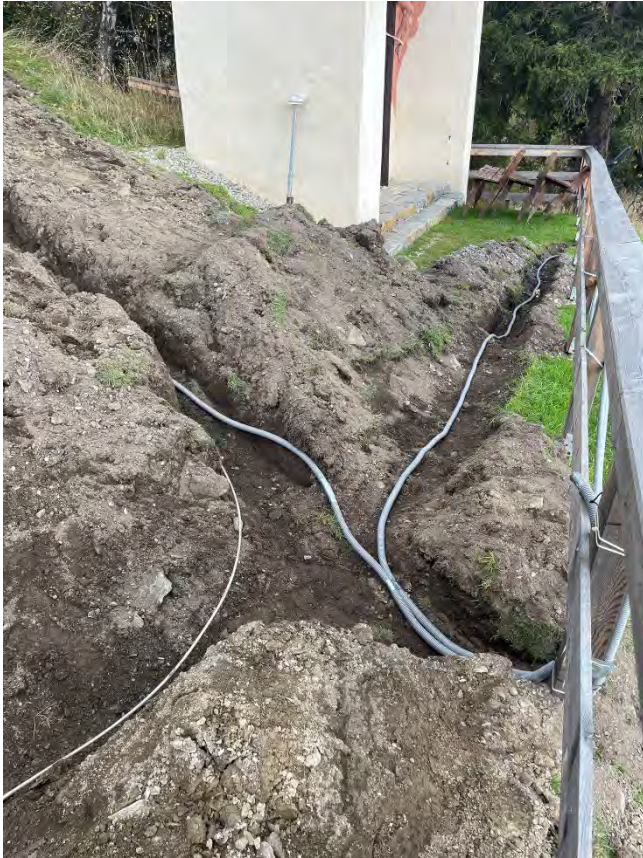
Leerverrohrung - Kabelleitungen für Außenbeleuchtung
