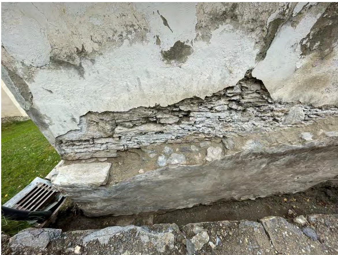
Zementputzabnahme in der Sockelzone > austretende Salzausblühungen nach Abnahme der Zementverputzung (1968)
