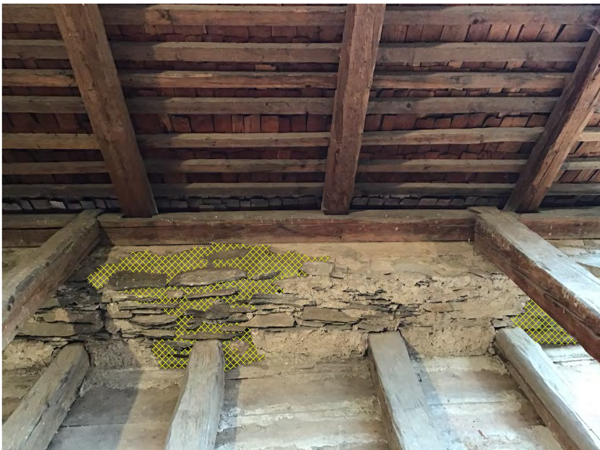
Kartierung Putzreparaturen & Vermauerungen 2024 DB Langhaus 3
