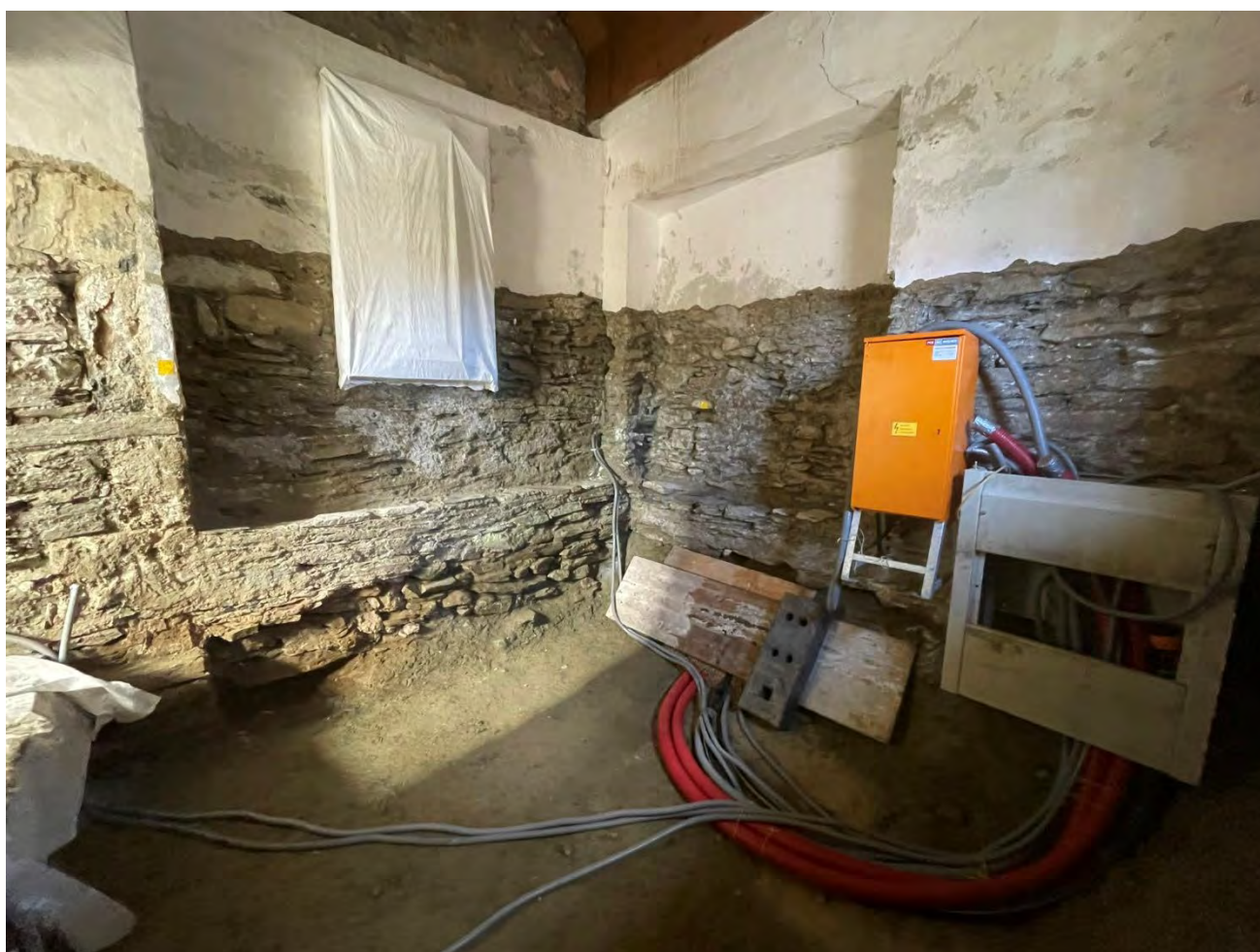
Provisorische Montage des Stromverteilers in der Sakristei (mit positionierter Leerverrohrung)
