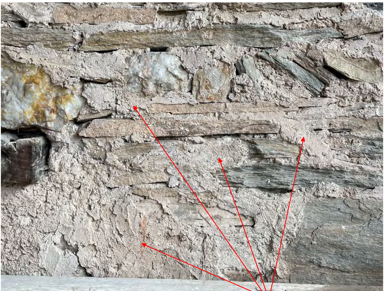
Detailaufnahme spätromanische Restbestände 1265/78 > geglätteter Fugenstrich im Setzmörtel
