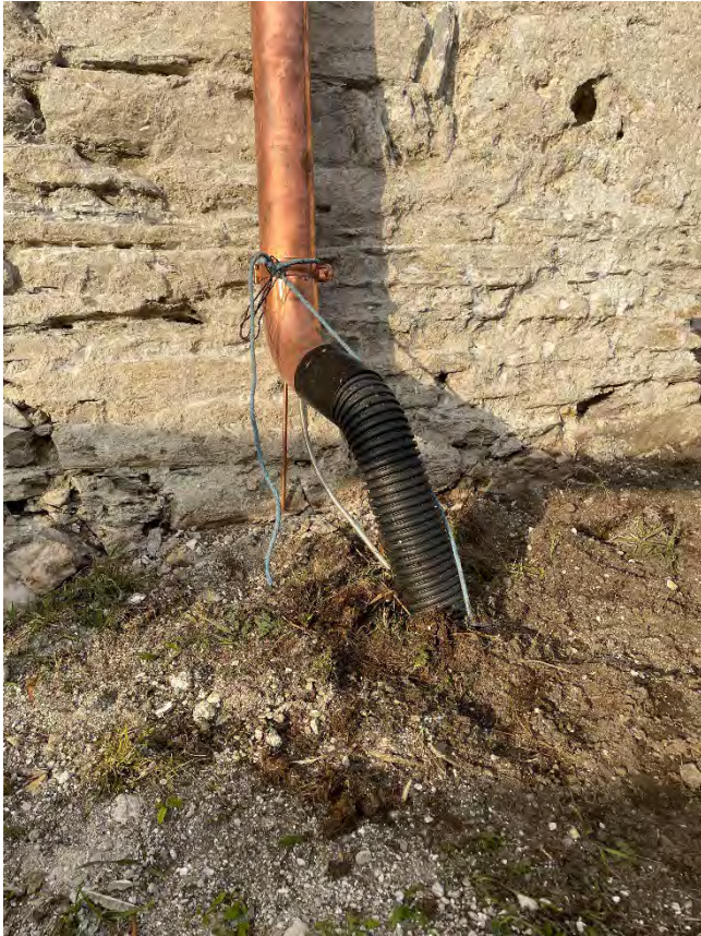
Provisorische Verrohrung im Erdreich Südseite
