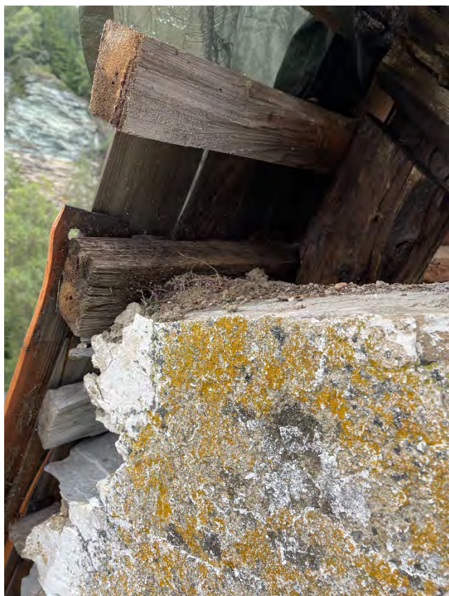
Fehlende Giebelvermauerungen sowie Putzmörtelausbrüche
