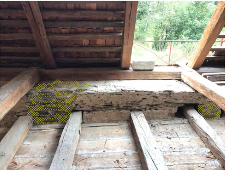
Kartierung Putzreparaturen & Vermauerungen 2024 DB Langhaus 4
