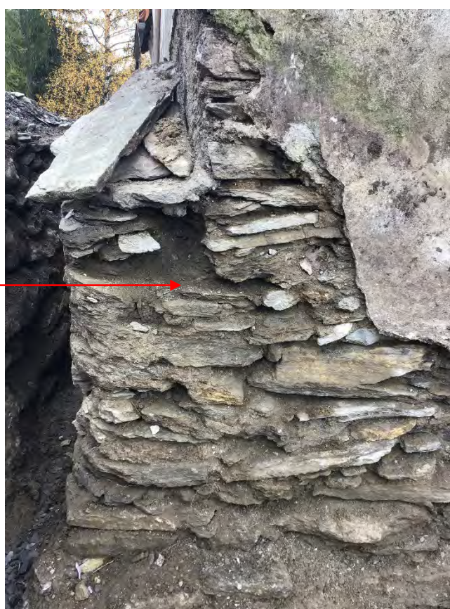
> Schadensbild durch den jahrzehntelangen Feuchtigkeitseintritt (Foto: Oktober 2024)
