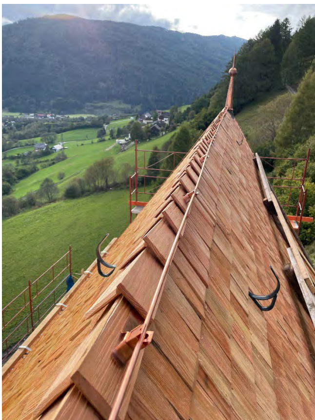
Halterungen Schindeldach > jede 5te Reihe
