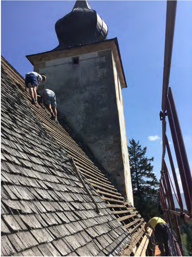
Abbruch des alten Schindeldaches > die Holzlattung besteht seit 1886
