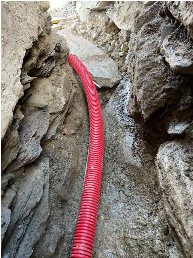
Leerverrohrung - Kabelleitungen für Außenbeleuchtung
