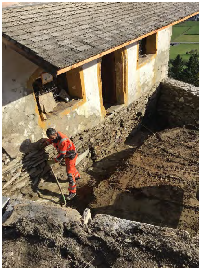
nach Abnahme des Erdreiches > vorspringende Felsanlage am Kirchenfundament
