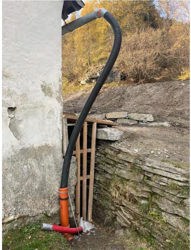
Provisorische Verrohrung im Erdreich Ecke Sakristei Nord/Ost
