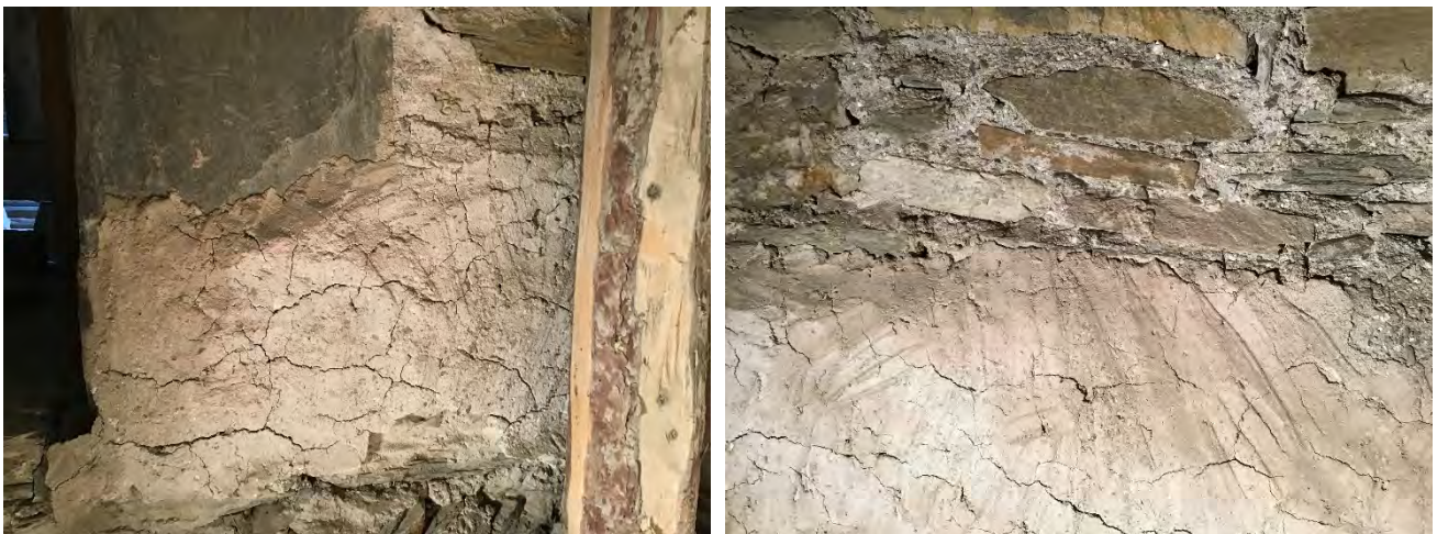
Detailaufnahmen spätrömische Restbestände > darüberliegend spätgotische Putzreparaturen & Reste der färbigen Kalktünche (Turmgeschoss West, Süd & Ostseite)
