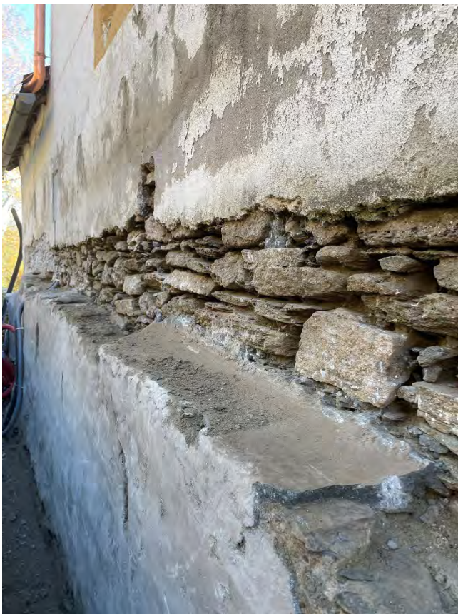
Abnahme des Zementmörtel an der Sockelzone & Auskratzen des erweichten Setzmörtels aus dem Bruchsteinmauerwerk
