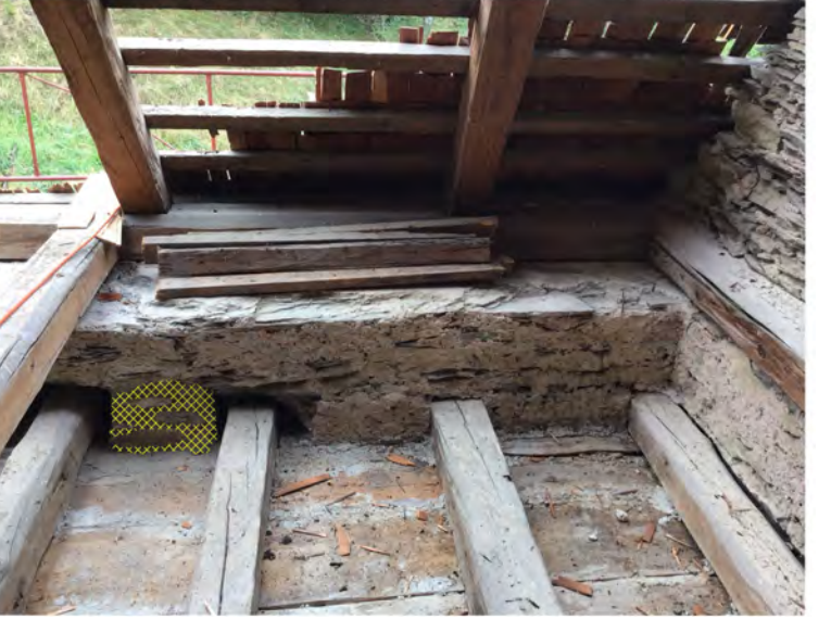
Kartierung Putzreparaturen & Vermauerungen 2024 DB Langhaus 5
