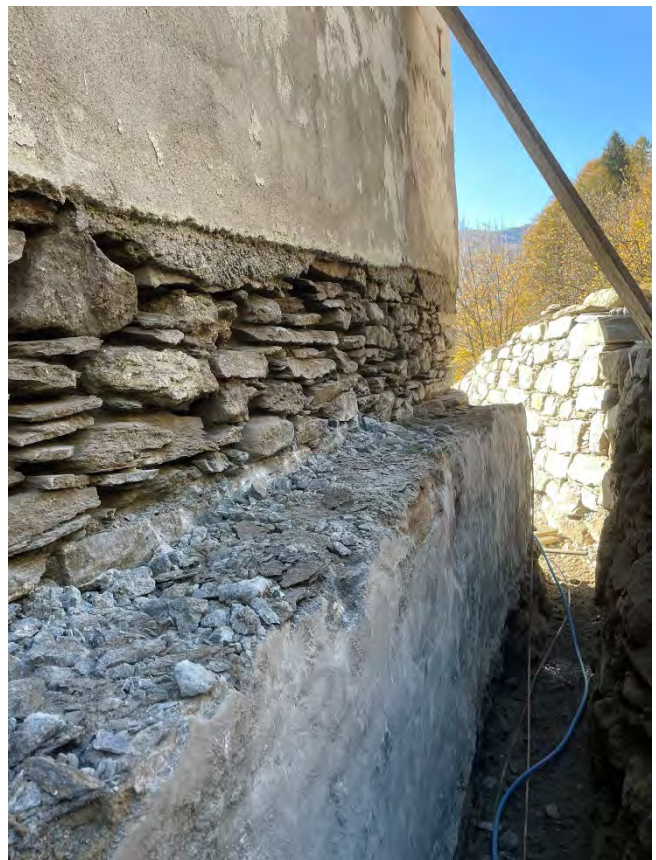
Abnahme des Zementmörtel an der Sockelzone & Auskratzen des erweichten Setzmörtels aus dem Bruchsteinmauerwerk
