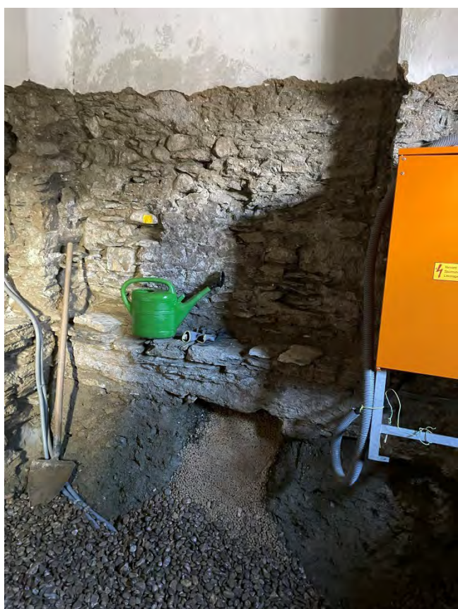
Diffusionsoffene Bodenschüttung mit Rundkorn 16/32
