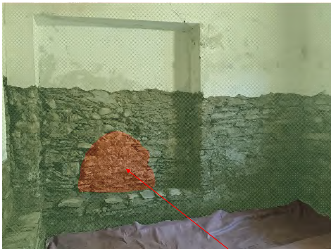
Kartierung Architekturfläche – Sakristei Nordseite → historistischer Mauereinbruch
