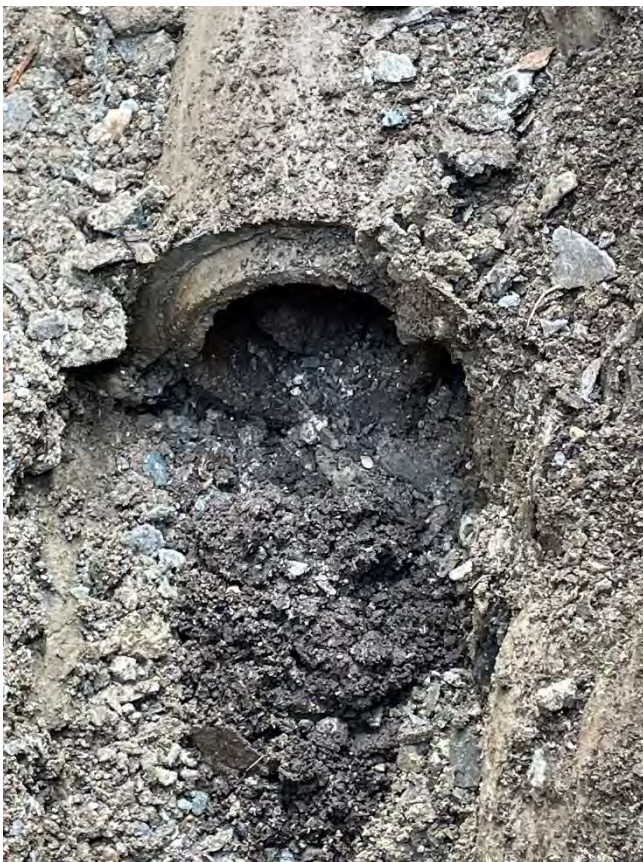
Öffnen des Entwässerungsgrabens (1968) > Drainagierungsrohr von 1968 in der Verschüttung > Auslauföffnung an der Nord/Ostecke Sakristei (frei auslaufend im Erdreich)
