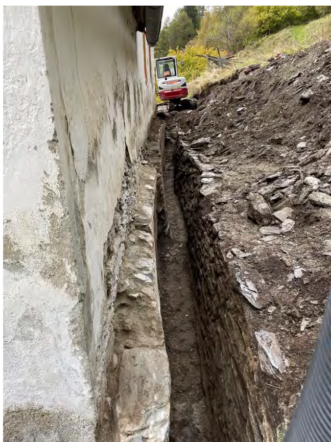
Während der Wiedererrichtung des zugeschobenen Entlüftungsgrabens (1968)
