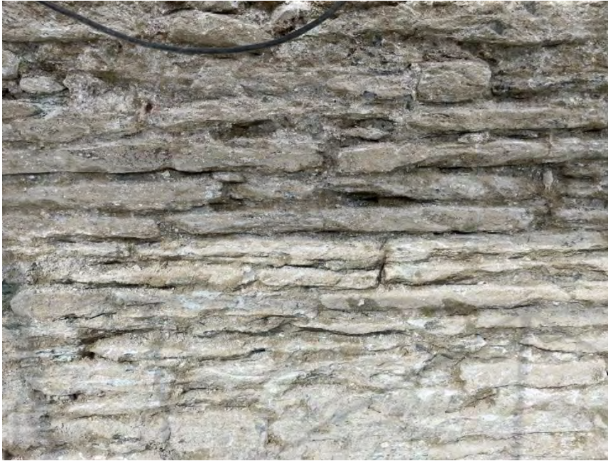
Entfernung des Zementmörtels (1968) aus dem Setzmörtel aus der Erbauungszeit
