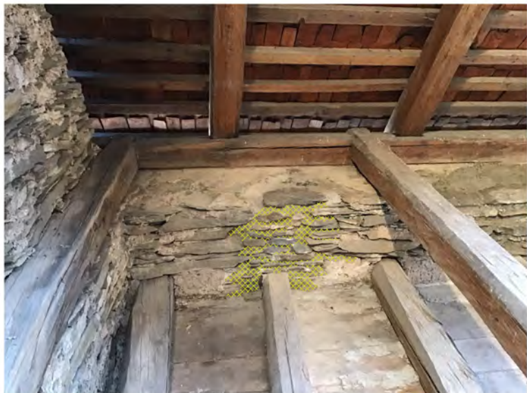
Kartierung Putzreparaturen & Vermauerungen 2024 DB Langhaus 2
