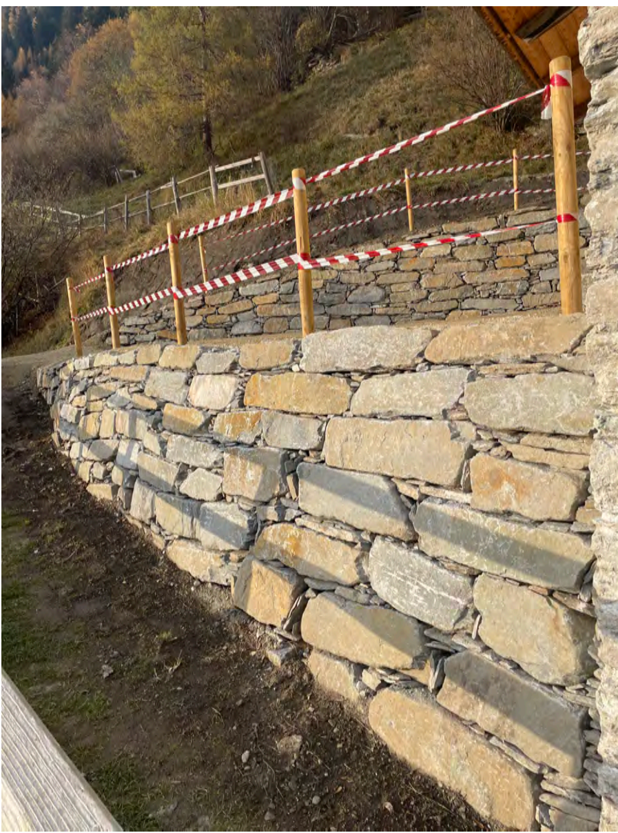
Foto: Trockensteinschichtung- Errichtung 2024 > Trockensteinschichtung mit Hinterlüftungsschotter 16/32 > mit Drainage sowie Fliespaket
