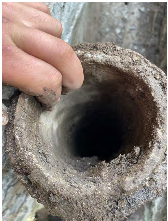
Öffnen des Entwässerungsgrabens (1968) > Drainagierungsrohr von 1968 in der Verschüttung > Auslauföffnung an der Nord/Ostecke Sakristei (frei auslaufend im Erdreich)
