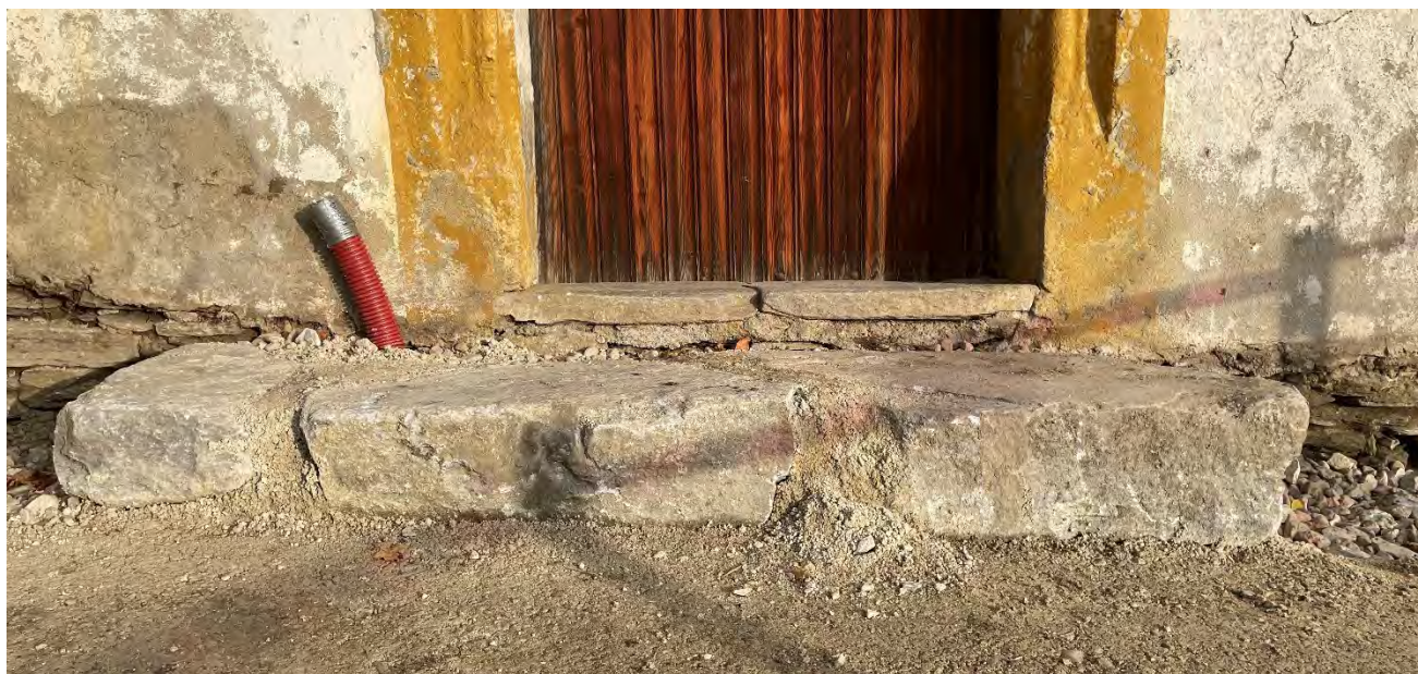
provisorische Stufenanlage Eingangsportal West – für den weiteren Kirchenbetrieb
