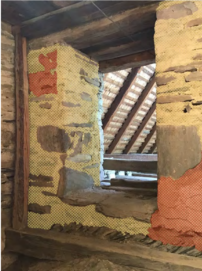
Kartierung Architekturoberflächen Turmgeschoss 2
