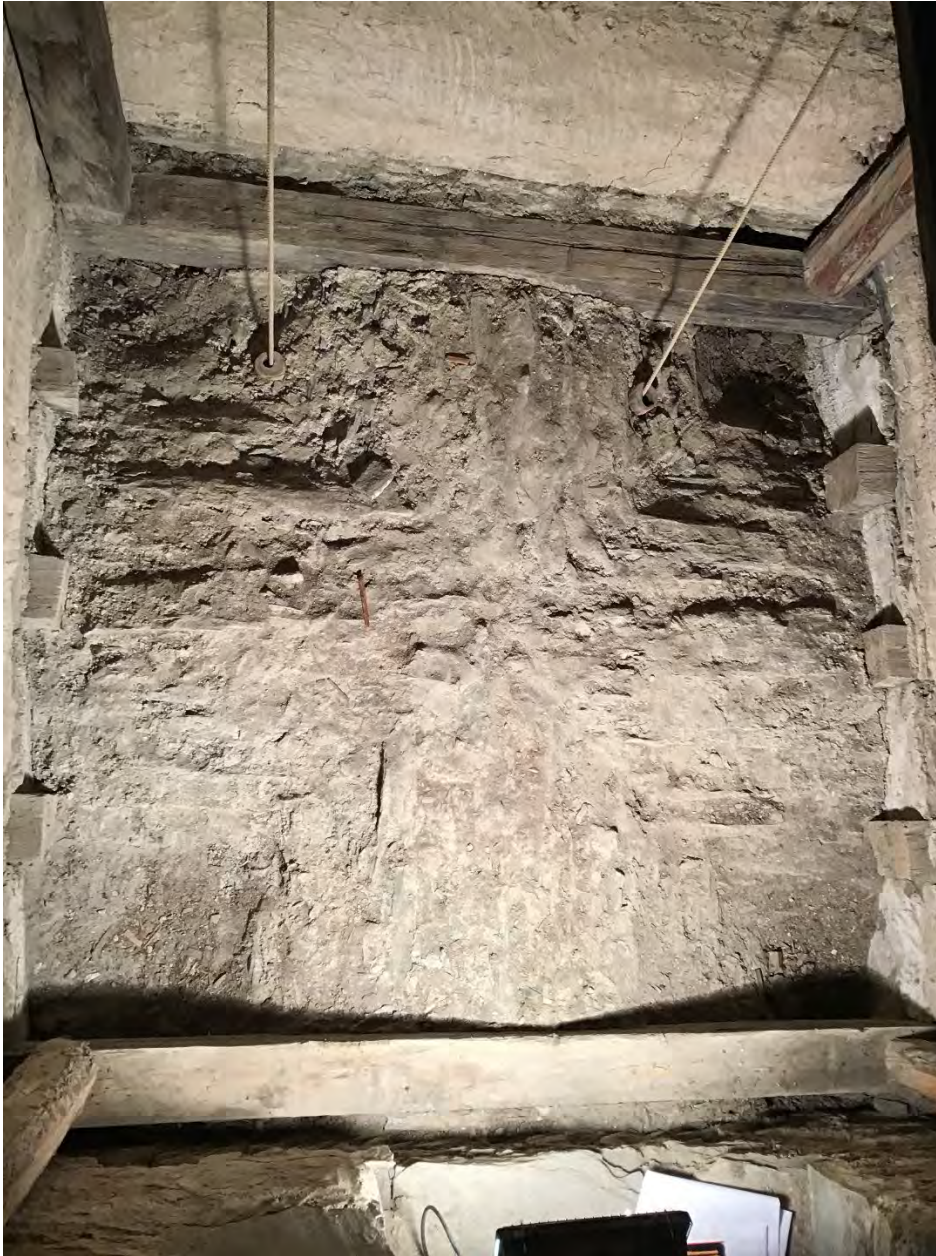
Turmgeschoss nach Entfernung des Bauschuttes (Draufsicht Kreuzgewölbe 1650)
