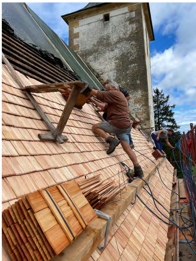
Eindeckung mit Lärchenschindeln (L: 50cm)
