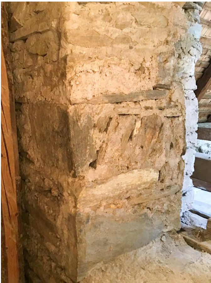
Detailaufnahme Bruchsteinmauerwerk > in Kalkmörtel gelegter Steinverbund, steinsichtiger Verputz
