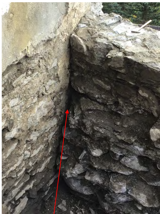
angesetzte Bruchsteinmauer
