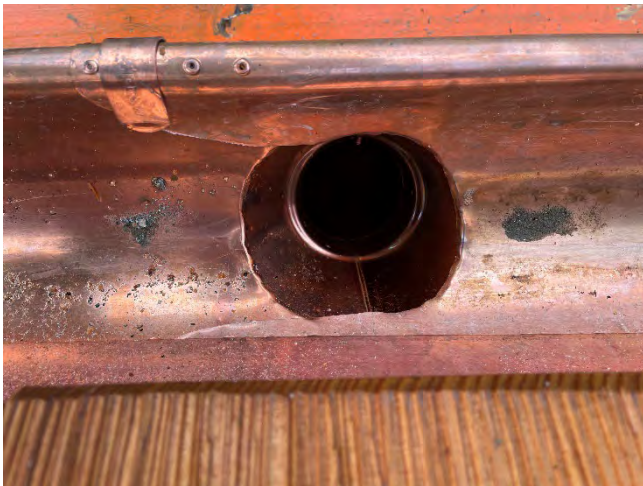
Einlaufrohr mit Verlötung
