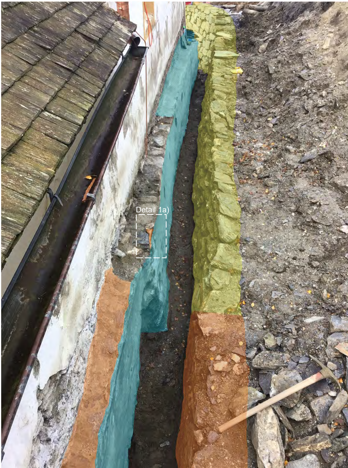
Entlüftungsraben - Putzkartierung / Kartierung des letztlich sichtbaren Bestandes (Oktober 2024)
