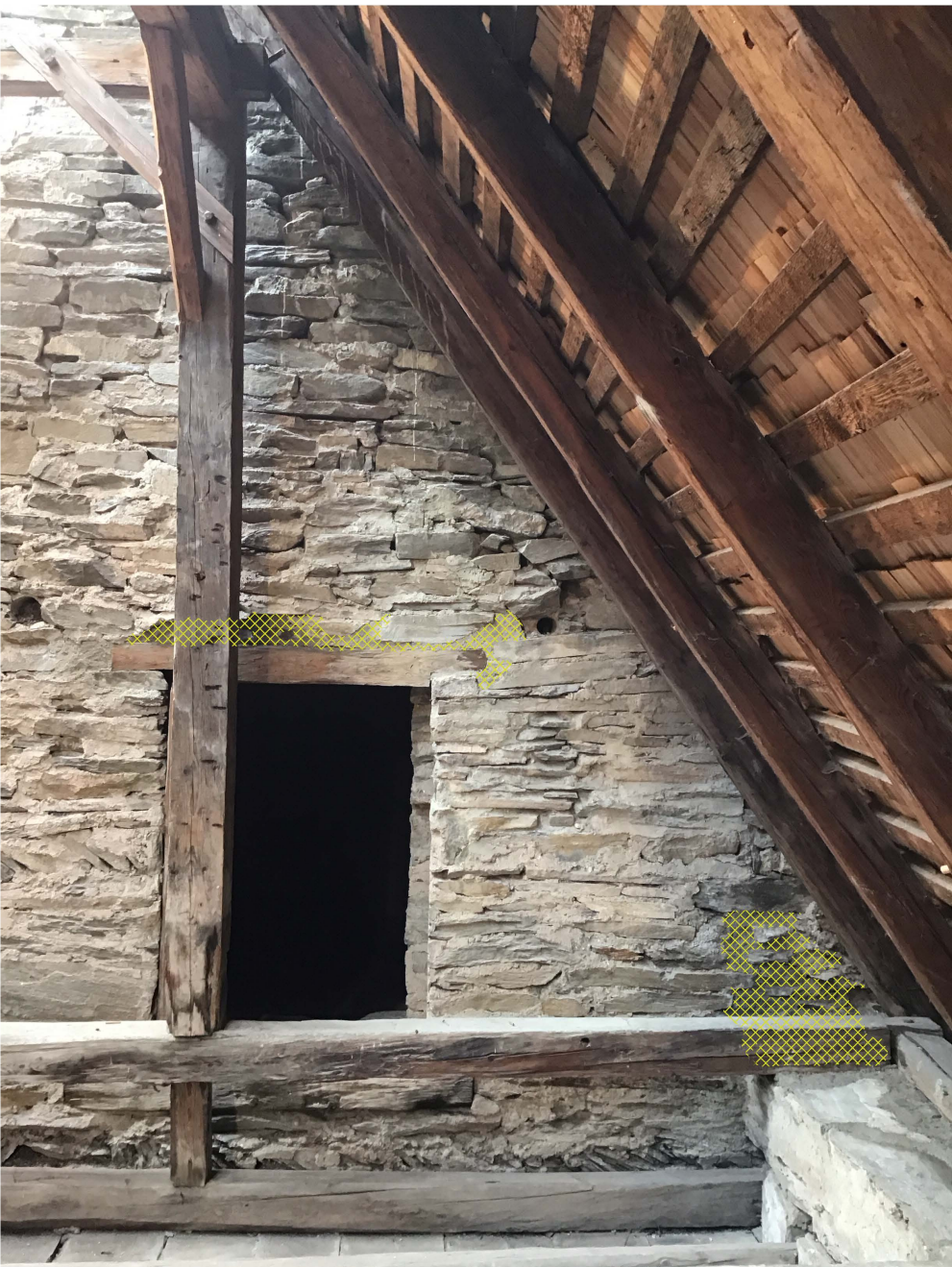
Kartierung Putzreparaturen & Vermauerungen 2024 DB Langhaus 1
