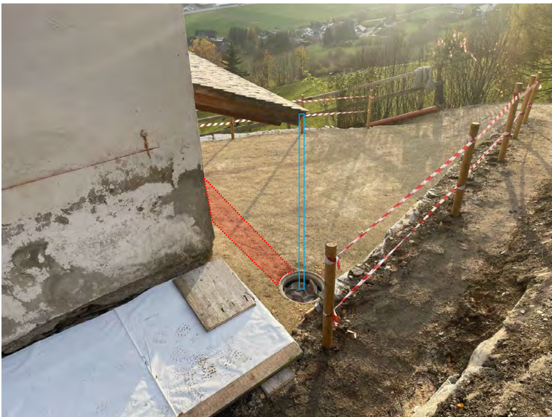
Eingangsbereich West: vorbereiteter Einlaufschacht für das Oberflächenwassers vom Pultdach mit Anschlussverrohrung der Drainagerohre (nord- & westseitig)
