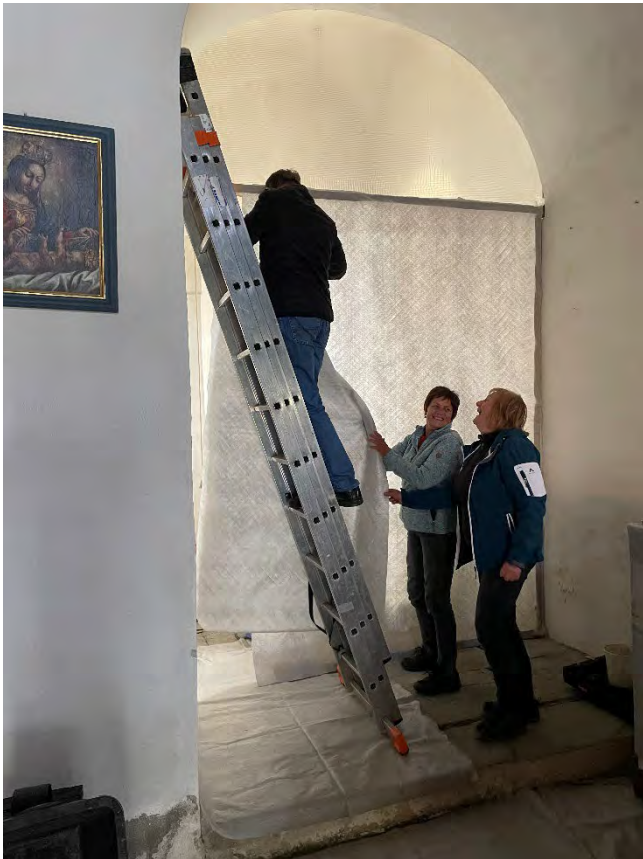
Errichtung einer provisorischen Staubwand
