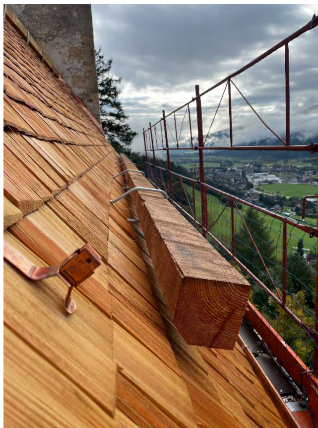
Anbringung von Schneefangbalken (Nord- & Südseitig)
