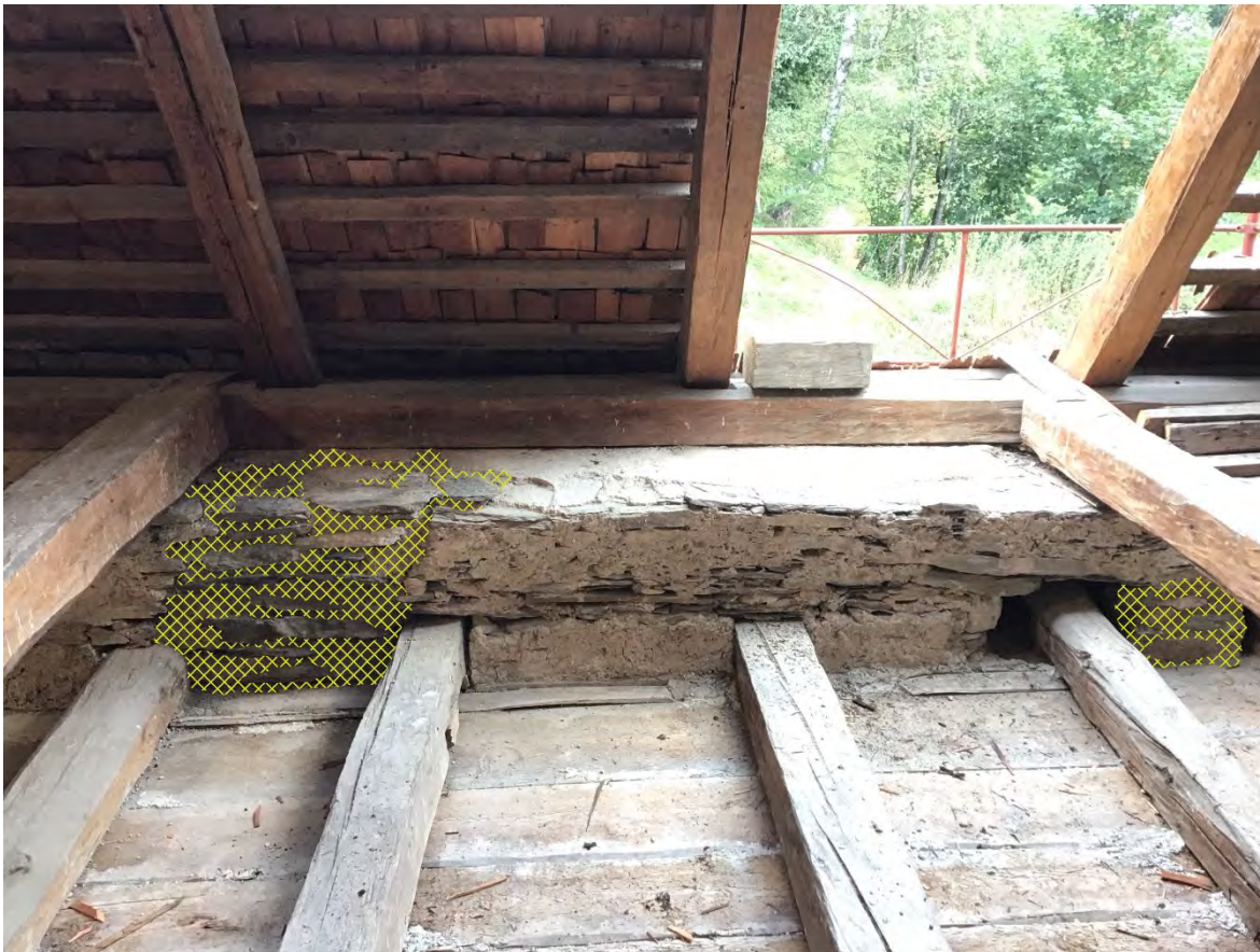
Kartierung Putzreparaturen & Vermauerungen 2024 DB Langhaus 4
