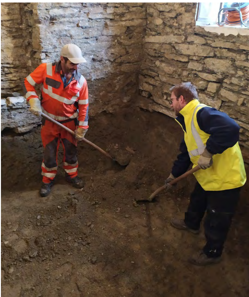
Händischer Aushub des feuchten Erdreiches (Tiefe: 60cm, unter Archäologischer Begleitung)
