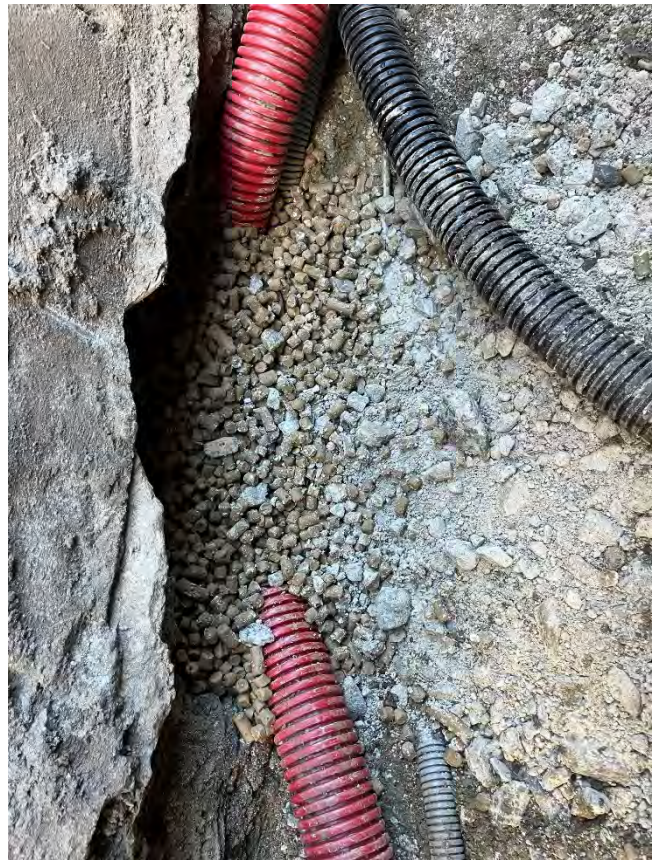
Verrohrung unterhalb der Fundamentzone > Stromanschluss Sakristei
