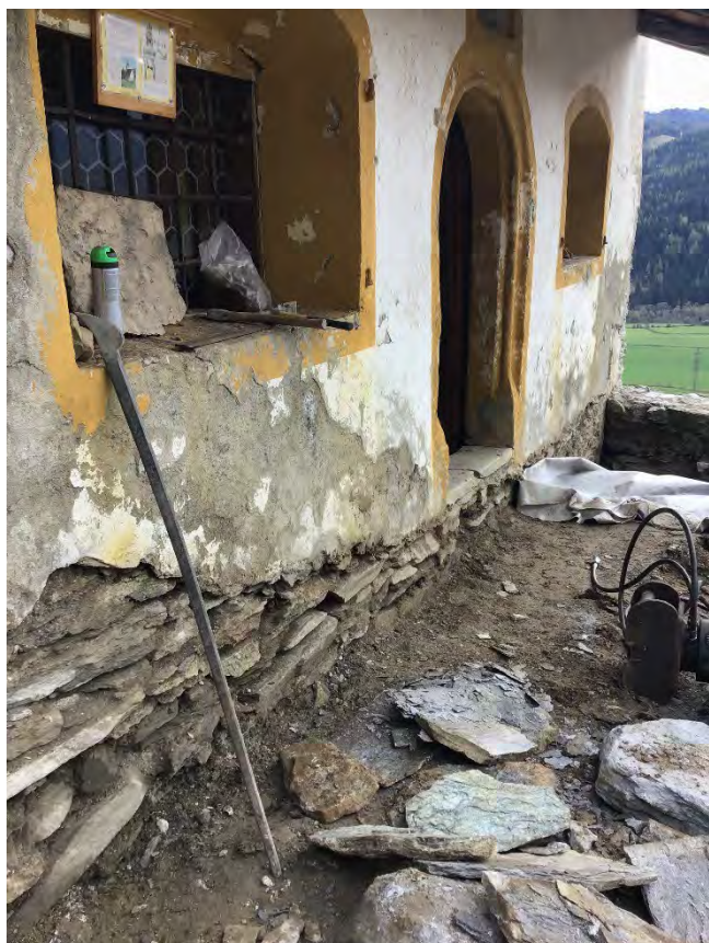
Grabungsarbeiten für die Drainagierung der Westseite
