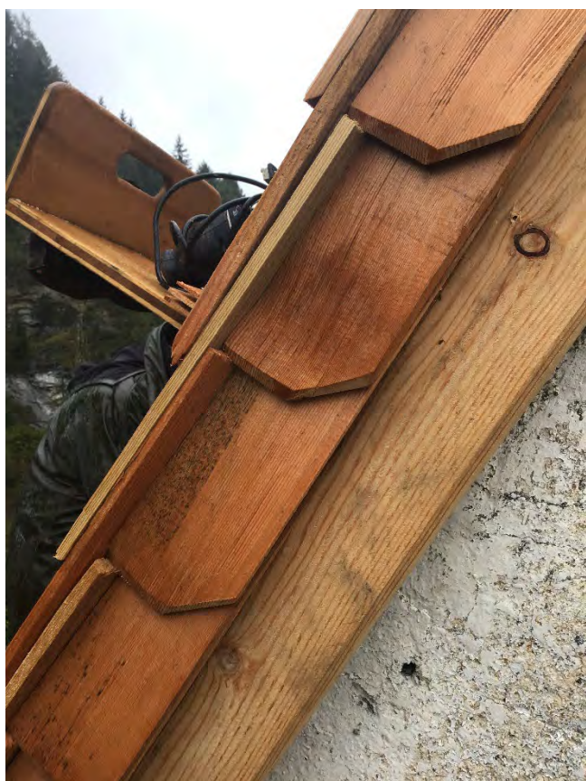
Gedeckter Ortgang an der Westgiebelmauer
