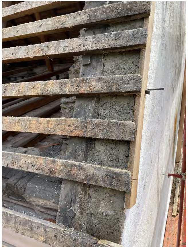
Dachlatten: 1886, Gattersäge > mit Putzmörtelreparaturen an der Giebelmauer
