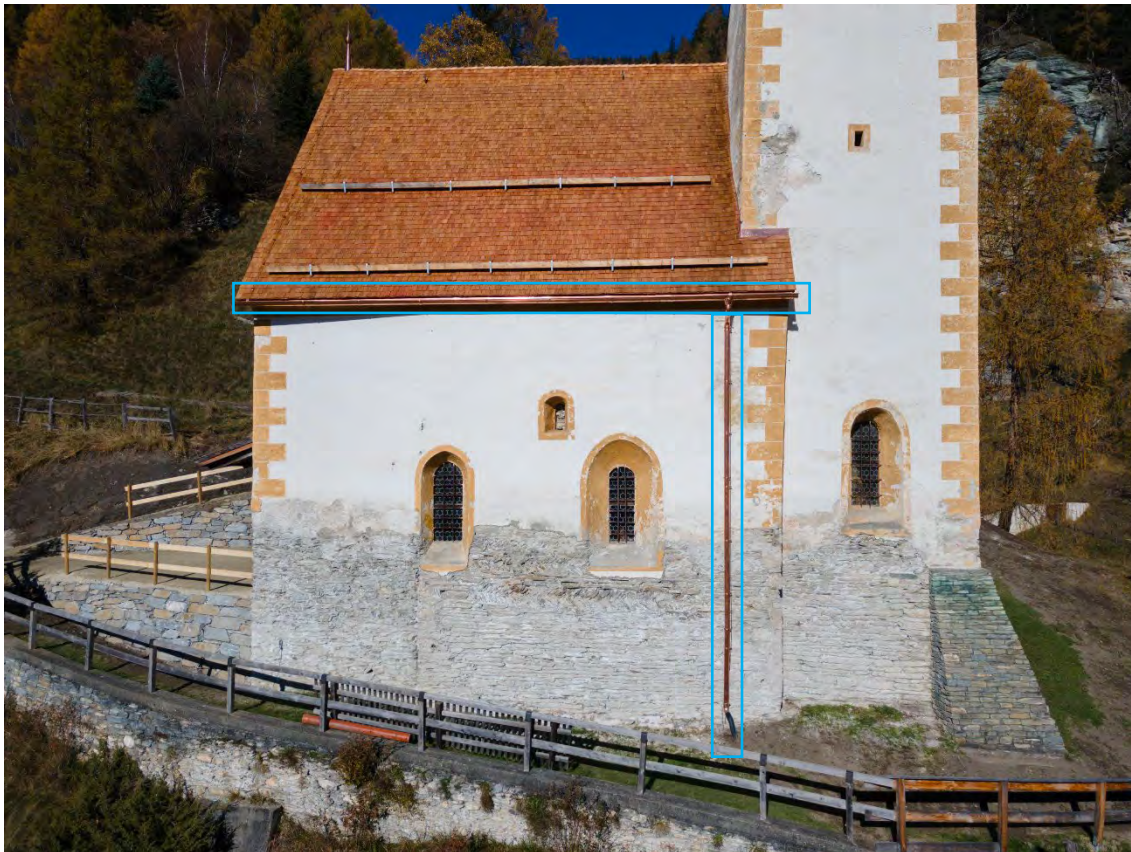
Oberflächenwasserableitung Südseitig
