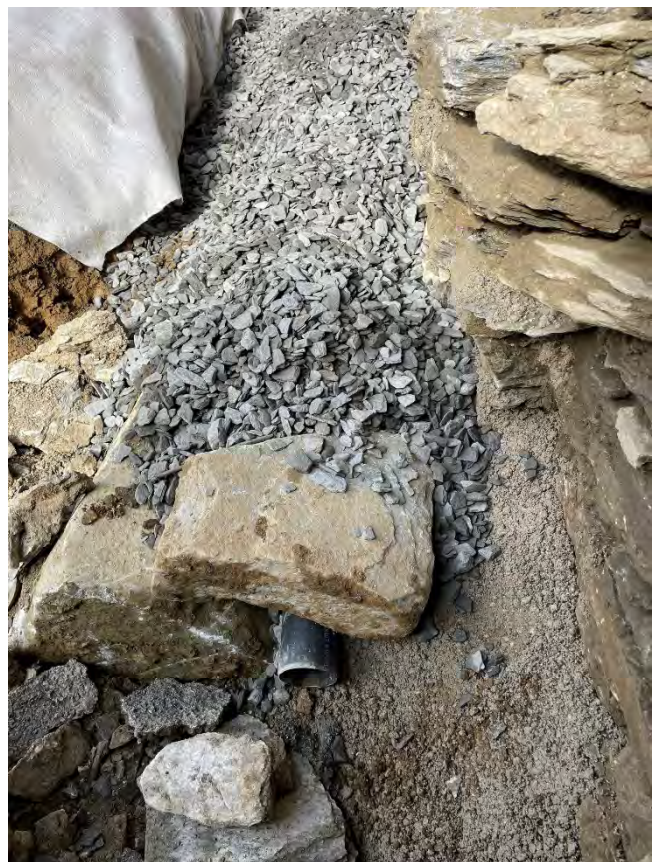
Fundamentauflager für die Trockenschichtung mit Hinterfüllung Bruchkornkies 16/32
