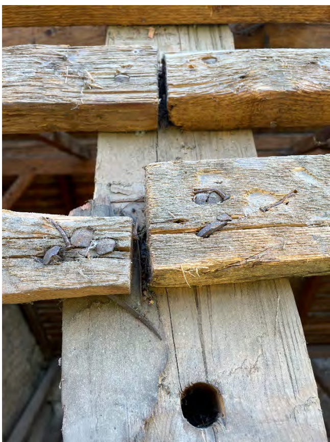
Nägel handgeschmiedet – verwendet 1886 (erstmalige Vernagelung), 1928, 1964/68, 2024
