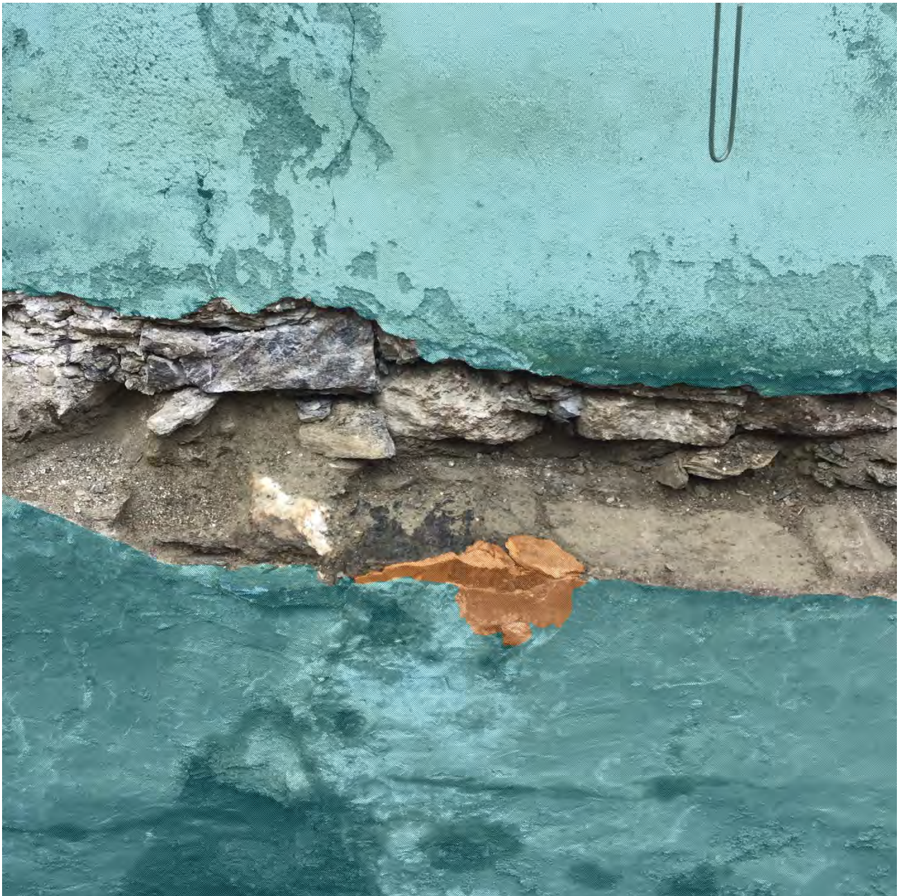
Detail 1a) Putzkartierung / Kartierung des letztlich sichtbaren Bestandes (Oktober 2024)
