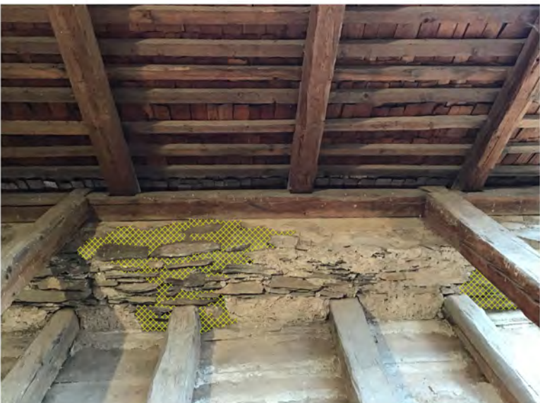
Kartierung Putzreparaturen & Vermauerungen 2024 DB Langhaus 3
