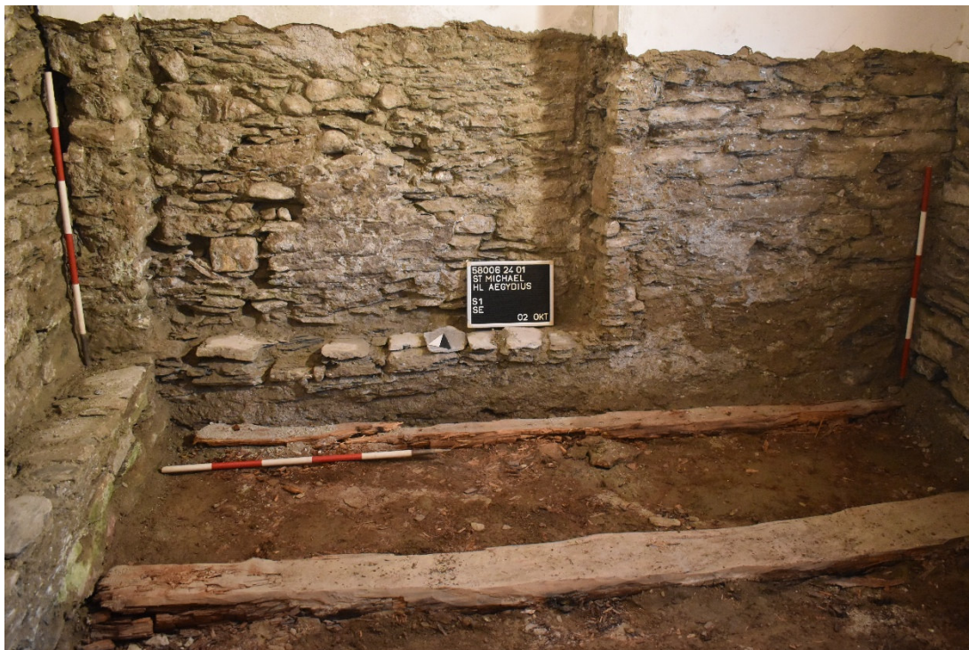
Überblick Sakristei von Süden mit Holzbalken des bereits abgetragenen Fußbodens (Foto: A. Tadic, Fa ARDIG)
