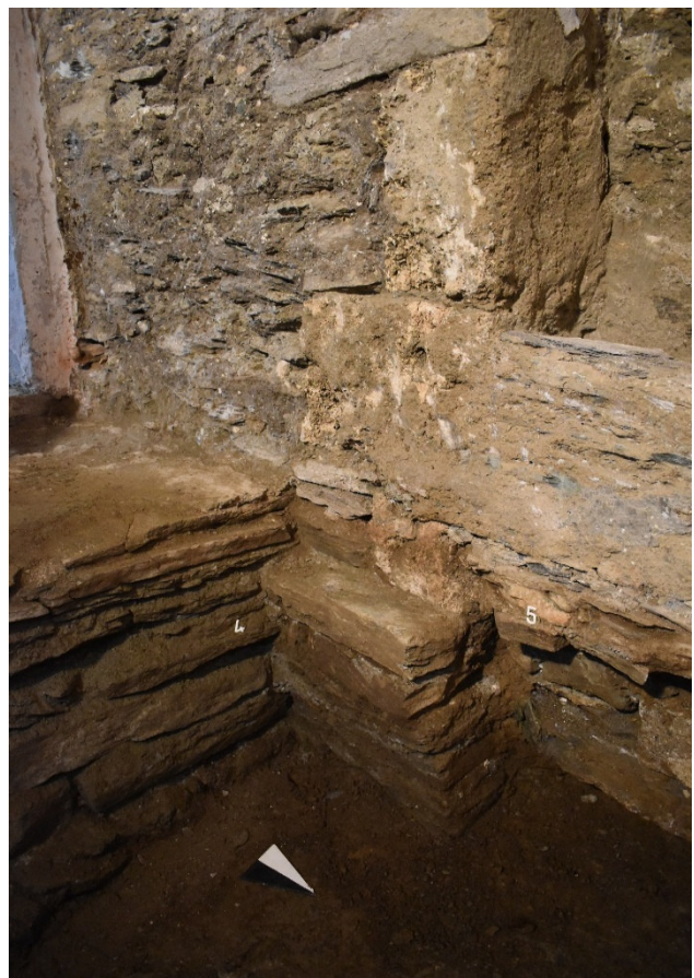
Links: östliche Sakristeimauer (SE 7), rechts: westliche Sakristeimauer (SE 5), die jeweils an die romanische Turmmauer ansetzen (Foto: A. Tadic, Fa ARDIG)
