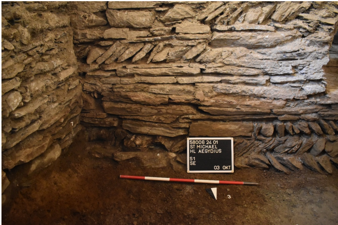
Romanische Turmmauer mit „Fischgrätenmauerwerk“ Teilabschnitten (Foto: A. Tadic, Fa ARDIG)
