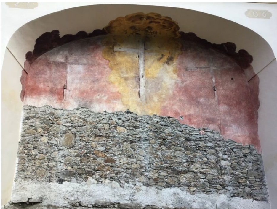
Foto: Mauerwerk Kalvarienbergnische nach Freilegung und Abnahme der Dispersionsfarbe; > Abnahme der versalzten Zonen und zementhaltige Putzreparaturen sowie der Weißzementkittungen an den Rissen und Gewölbe > Freigelegter Restbestand der Hintergrundmalerei; Zementputzmörtelabnahme mit sichtbarem Bruchsteinmauerwerk und Opferputz im Sockelbereich
