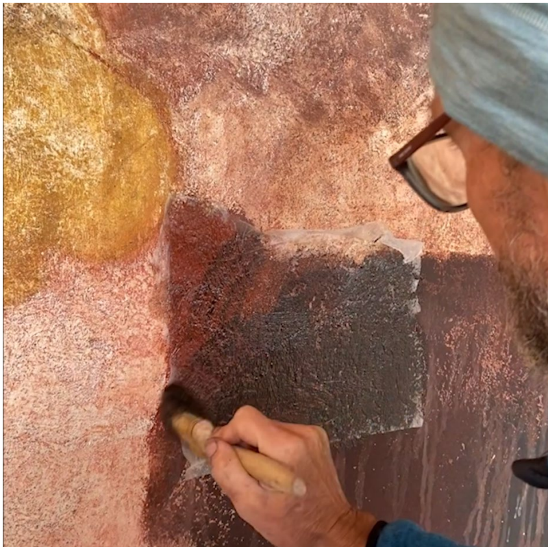
Foto: Dispersionsfarbabnahme mittels Gel und Japanpapierzwischenlage
