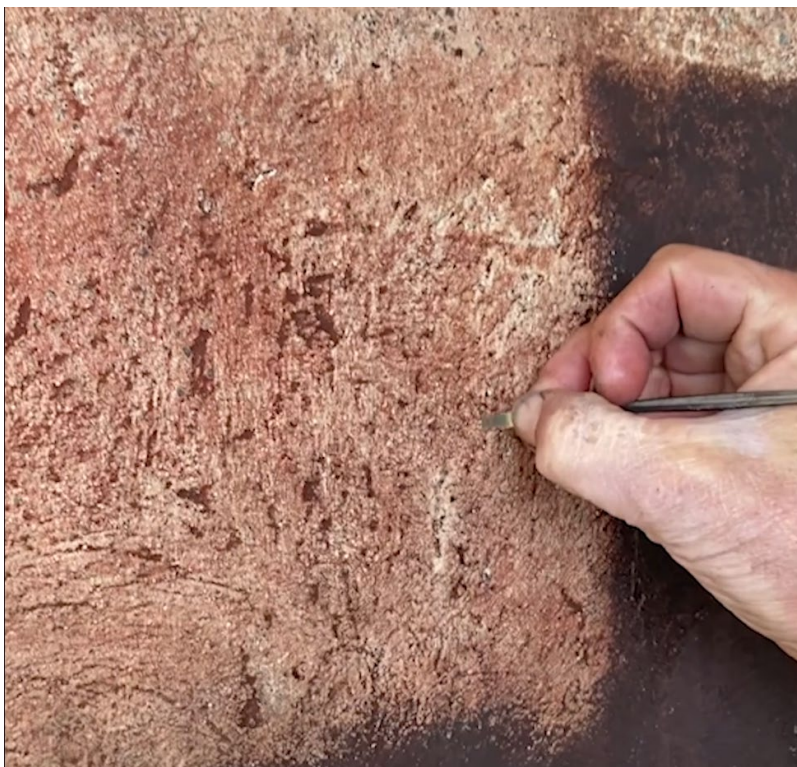
Foto: Nachreinigen der kleinflächigen Dispersionsfarbresten in den Tiefen
