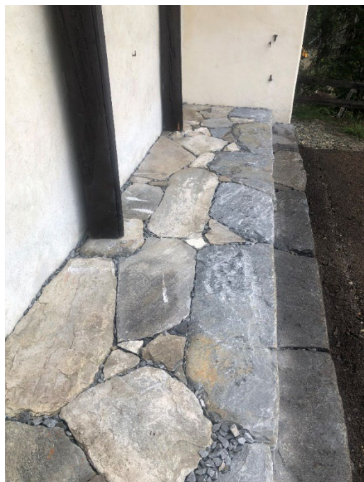
Fotos: nach Fertigstellung / Neugestaltung der Stufenanlage (Steinplattenschichtung) mit heimischem Material
