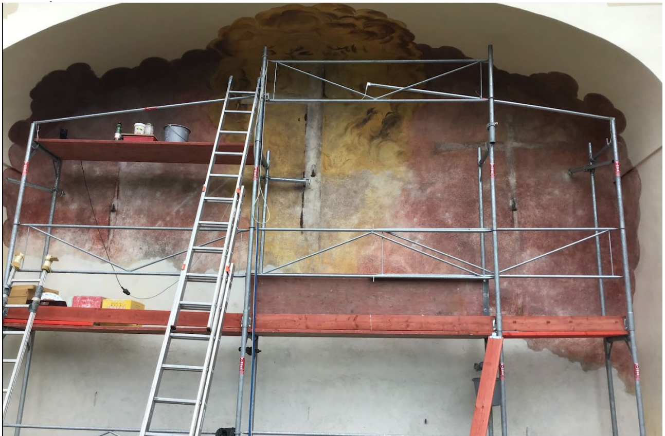
Foto: Putzmörtelergänzung ab dem mittleren Bereich bis an die Bodenkante (Trockengelöschter Kalkmörtel mit polierter Oberfläche)
